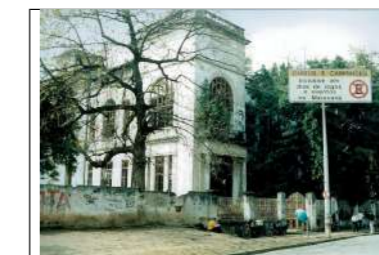
Fachada da Rua Mata Machado
