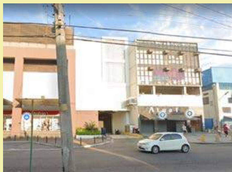
FIG. 14 - PRÉDIO SEM USO DO ENTORNO
