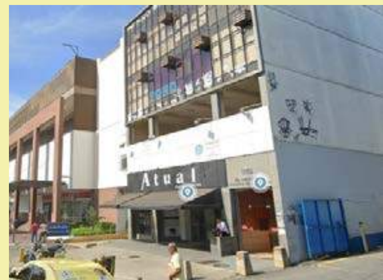
FIG. 15 - PRÉDIO SEM USO DO ENTORNO
