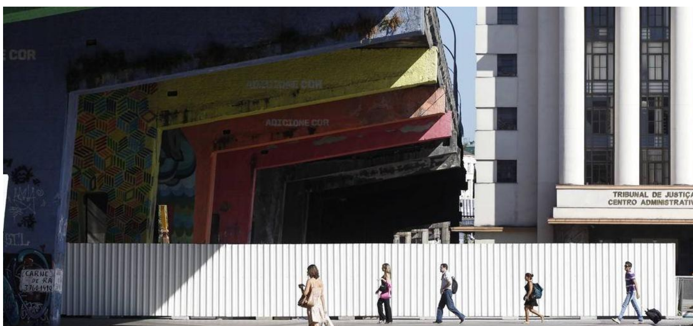
fig. 27 - Pablo Jacob. Início da instalação dos tapumes na Praça XV para as obras do Porto Maravilha . 2014. fonte: Agência O Globo.
