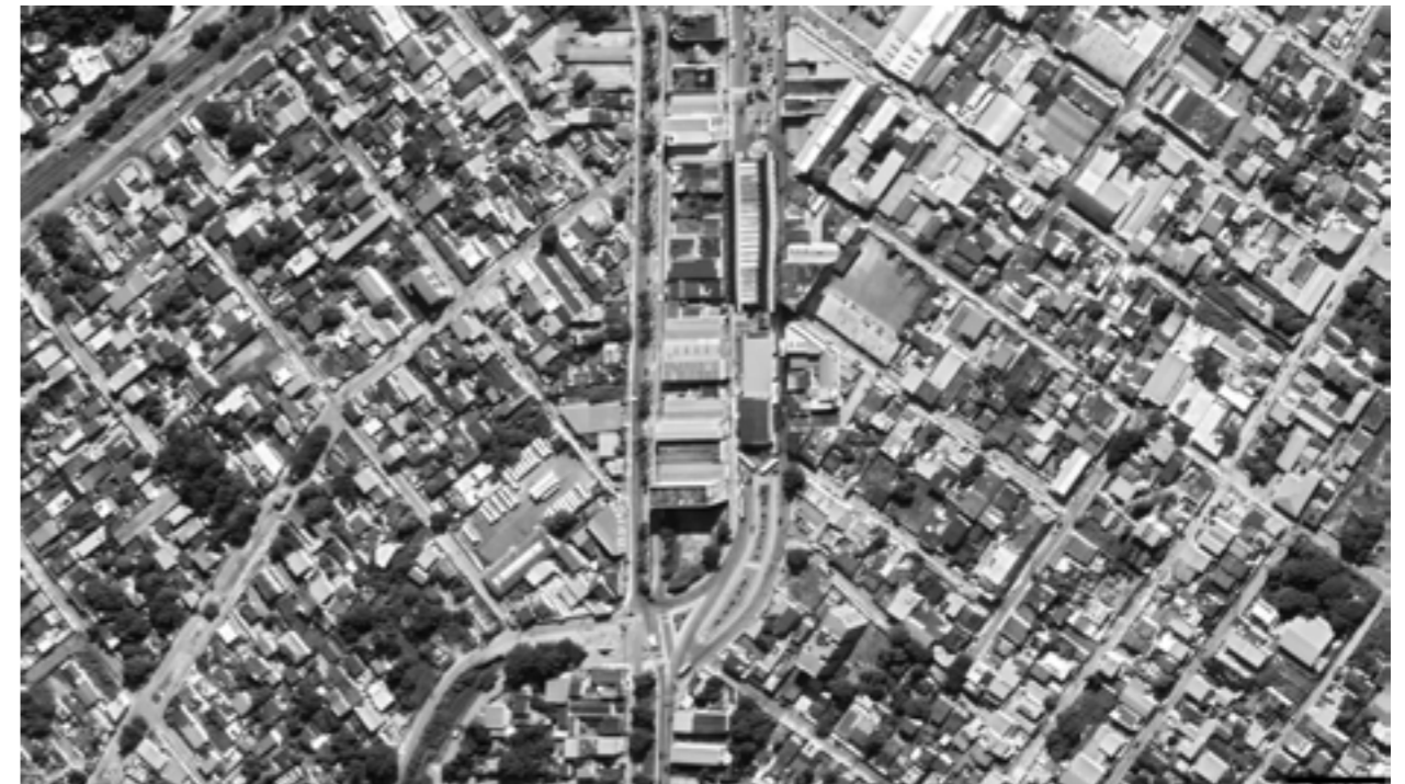
A rodoviária de Piabetá é dividida em dois blocos: o primeiro (acima) para ônibus locais e o segundo (abaixo) para ônibus intermunicipais. O edifício paulistano ocupa o lugar do primeiro bloco. O museu, no primeiro pavimento, apresenta em sua primeira exibição a exposição: “Exaltação à conversa fiada”. A Doméstica, participou ativamente das pesquisas e construção do acervo. O edifício logo ficou conhecido como Museu da Conversa. Na periferia o museu permanece em estado de mutação constante. Subestimaram o funcionalismo periférico.
