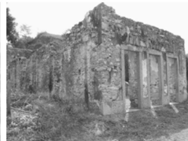
Casa das três portas (séc. XIX). A construção em ruínas tinha função comercial no antigo Porto da Estrela, Parque Estrela. Arquivo pessoal.
