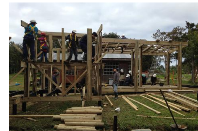
fig. 34 / Travesía / colocação vigas da cobertura e piso
