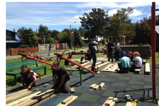
fig. 32 / Travesía / montagem dos pilares
