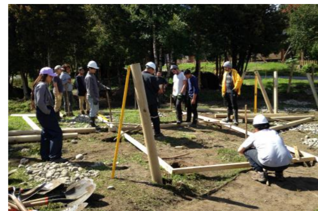
fig. 31 / Travesía / estruturação viga de piso
