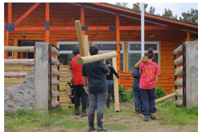
fig. 30 / Travesía / descarregamento de materiais
