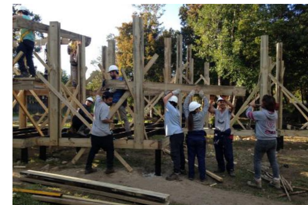
fig. 33 / Travesía / colocação vigas da cobertura
