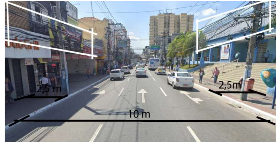
Figura 43 - Ruas Dr. Feliciano Sodré e Dr. Nilo Peçanha com cotas em preto e marcação do cabeamento área em excesso. Fonte: Google eath - Marcações do autor.
