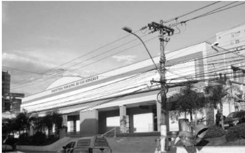
Figura 18 - Edifício 1 - Prefeitura Municipal de São Gonçalo
