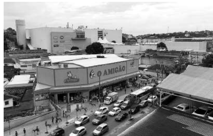
Figura 21 - Edifício 4 - Loja O Amigão - empreendimento recente que reativou uma frente de quadra que ficou por anos com uma construção murada e abandonada.
