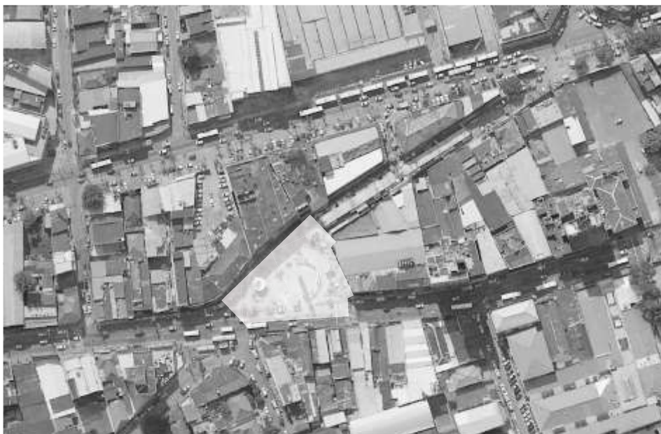
Figura 50 - Ortofoto com destaque em branco na área da Praça. Fonte: Google eath, street view - Marcações elaboração própria.
