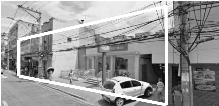
Figura 58 - Foto com destaque em branco nas edificações que serão demolidas. Fonte: Google eath, street view - Marcações do autor.
