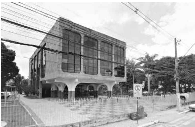
Figura 28 - Edifício 11 - Biblioteca Municipal - única biblioteca pública do município fechada em setembro deste ano (2019).
