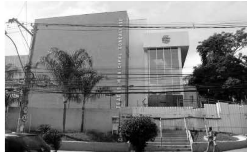
Figura 19 - Edifício 2 - Teatro Municipal
