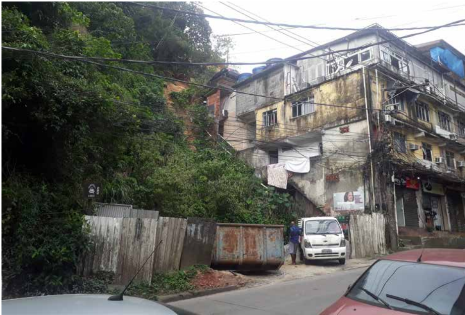
Imagem 52. Estacion. loja de mat. de construção - Rua 1. Fonte: Acervo pessoal, agosto de 2020.
