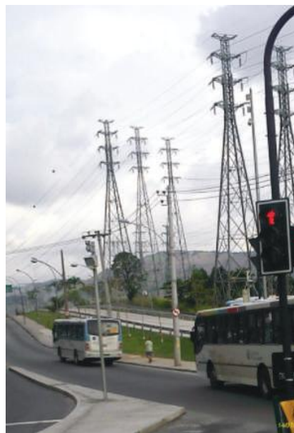
Imagens 26: Imagem ao lado - Vista do Acesso ao Viaduto Negrão de Lima , o corredor BRT Transcarioca , o rasgo considerado( área gramada ) e a área livre próxima a estação de trem Mercado de Madureira com as linhas de transmissão .
