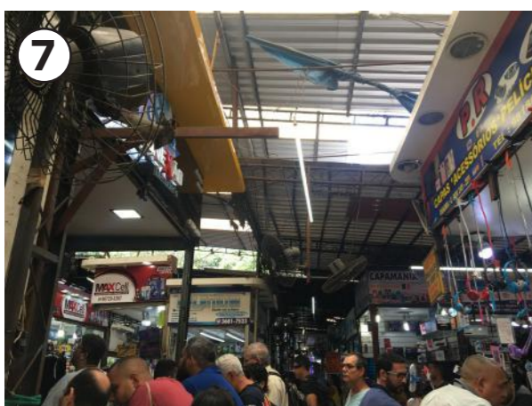
▲ Cobertura do Camelódromo
