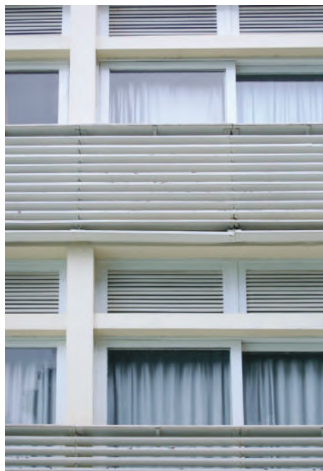
◀ Imagens 34 e 35: Hotel Cataguases – Aldary Toledo. Fonte: Guia da arquitetura modernista em Cataguases. Cataguases, MG: Instituto Cidade de Cataguases, 2012. p 32 e 37.
