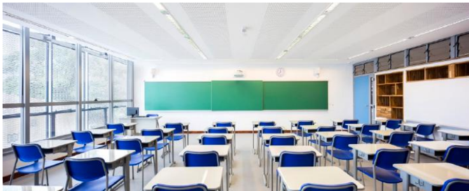
Imagem 64 – Vista interna com detalhe para o teto em gesso liso e gesso perfurado/ Fonte: Archdaily / Fotografia: Fernando Stankuns
