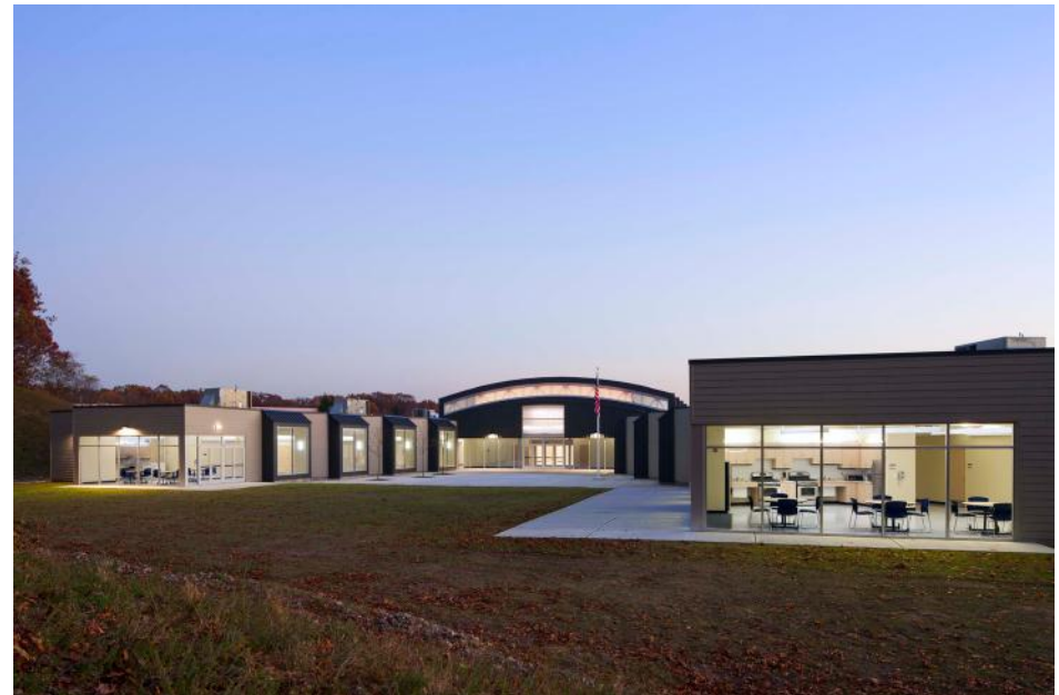
Imagem 79 - Fachada Principal REED Academy/Fonte: Archinet /Fotografia: Albert Vecerka/ESTO
