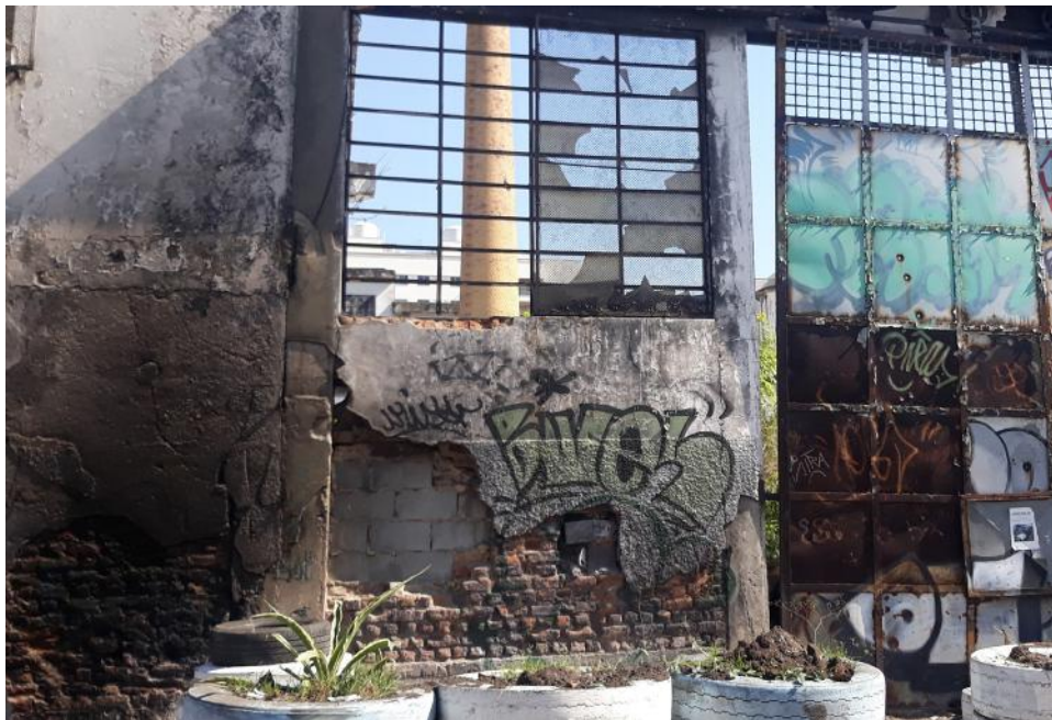
Imagem 105 - Vista do Terreno através da Rua Luisa Figueiredo, com destaque da chaminé ,ao fundo, existente no local e os tijolos de demolição presente na fachada/ Fonte: Autoria Própria
