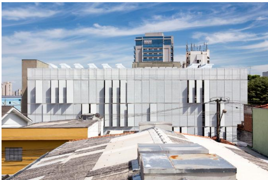
Imagem 62 - Fachada com detalhe para a chapa de alumínio - Escola Fundação Bradesco / Fonte: Archdaily / Fotografia: Fernando Stankuns
