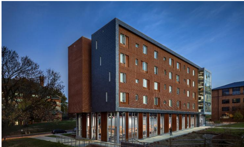
Imagem 53 - Fachada Oeste / Fonte: LTL Architects
