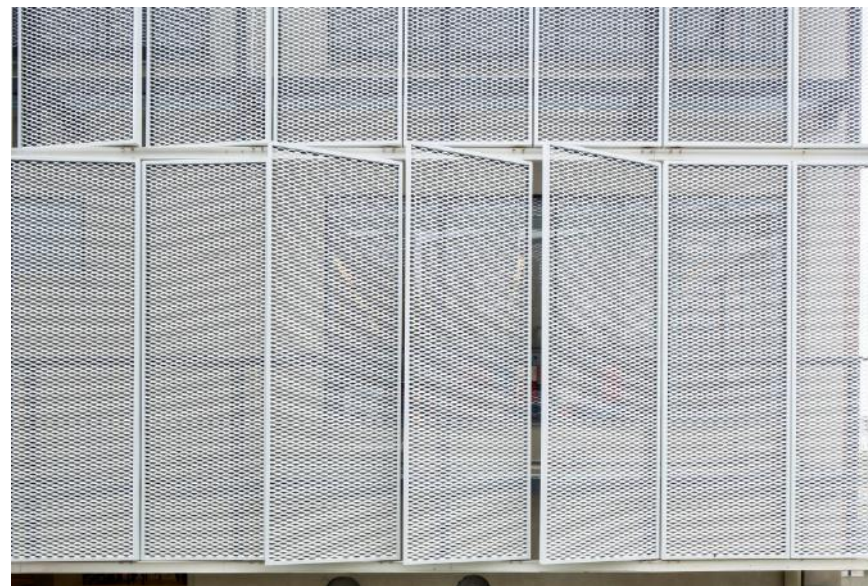
Imagem 63 - Detalhe fixação do sistema da chapa de alumínio/ Fonte: Archdaily / Fotografia: Fernando Stankuns
