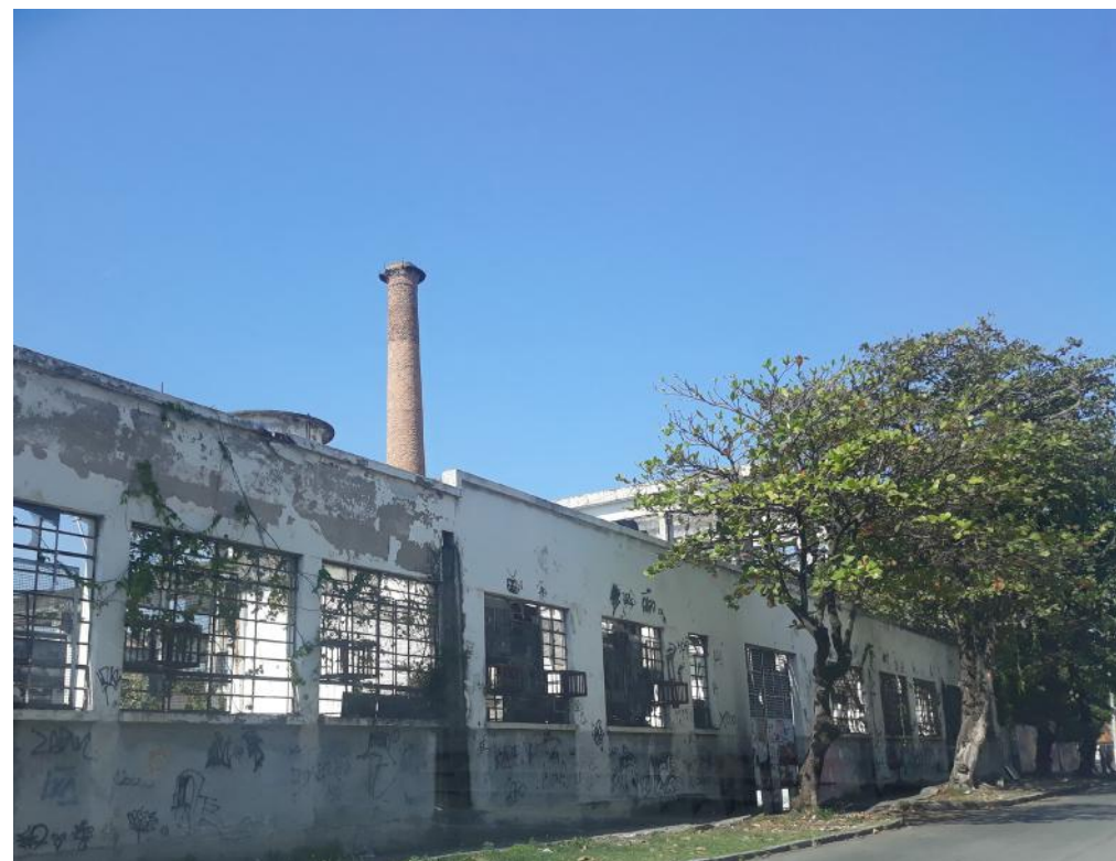
Imagem 104 - Vista do Terreno através da Rua Panama, com destaque para a chaminé existente no local/ Fonte: Autoria Própria
