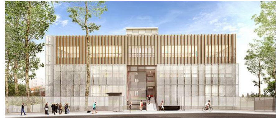
Imagem 61 - Fachada em Modelo 3D com detalhe para a chapa de alumínio e brises fixas em madeira / Fonte: Shied Arquitetos e Associados
