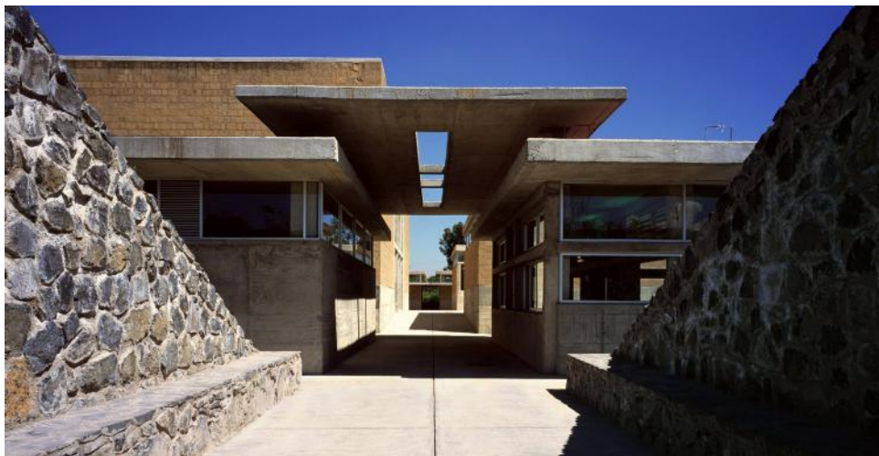
Imagem 38 - Corredor de um dos blocos do conjunto de edificações / Fonte: Luis Gordo
