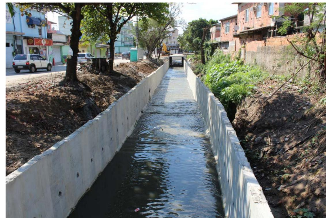
figura 40 - Canalização do Canal Moquetá (fonte: Nova Iguaçu, 2020)
