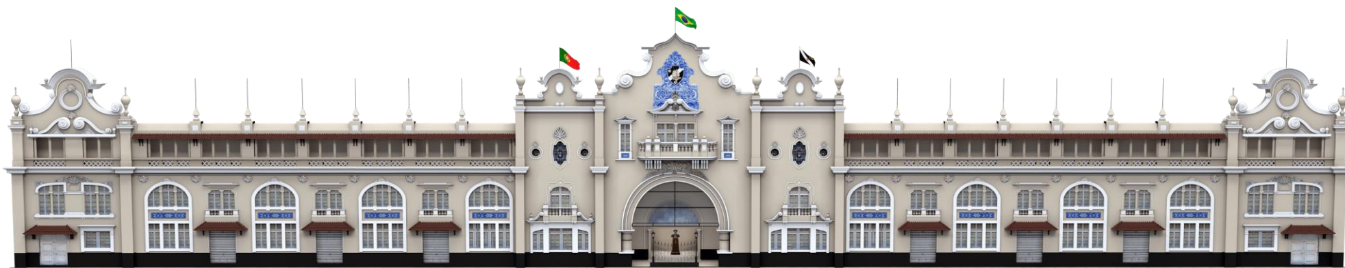
Figura 2 - Fachada Neocolonial do Estádio São Januário. Rio de Janeiro, 2020. Fonte: Globoesporte.com, 2020.
