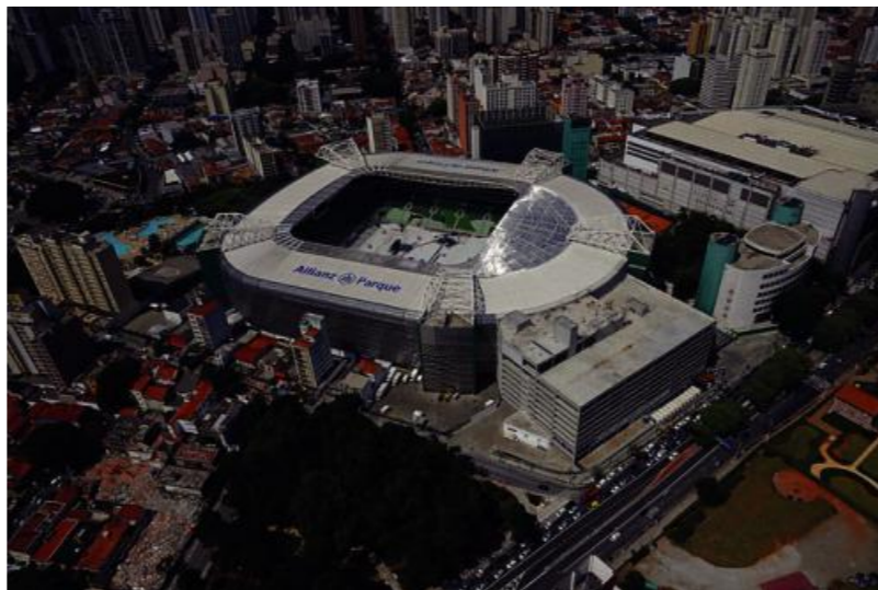
Figura 16 - Allianz Parque e Shopping Bourbon em São Paulo são exemplo de possíveis combinações programáticas atuais.
