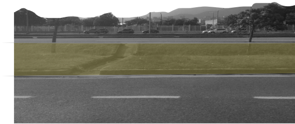
Distância entre calçadas na Av. das Américas. Em destaque canteiro central sem cobertura arbórea.
