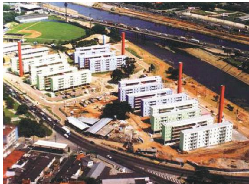
Fig 25- Foto aérea do empreendimento em construção demonstrando a repetição dos blocos Fonte: Jornalistas livres
