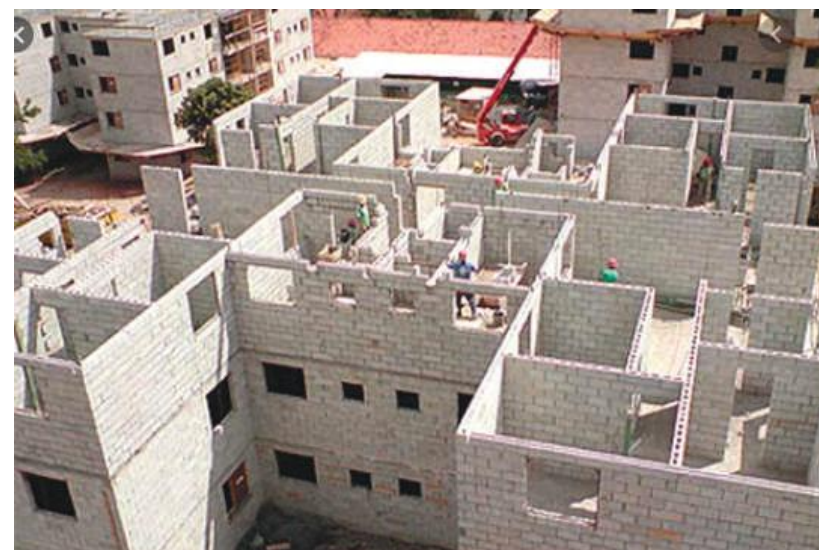
Fig 2 - Empreendimento sendo construído em alvenaria estrutural. Fonte: Fórum da Construção
