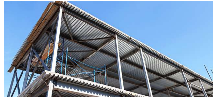
Fig 39 - Sistema construtivo steel deck+estrutura metálica Fonte: AecWeb
