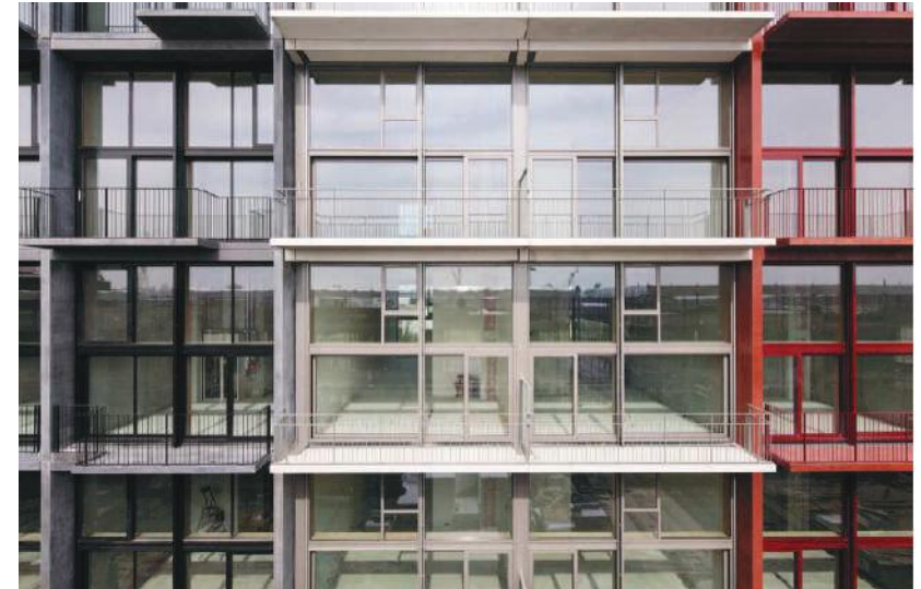
Fig 19- Fachada modular em alumínio Fonte: MKA
