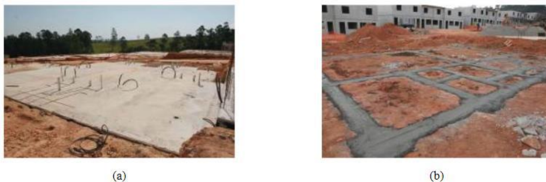
Figura 2.5 – (a) Radier e (b) Sapata corrida.
