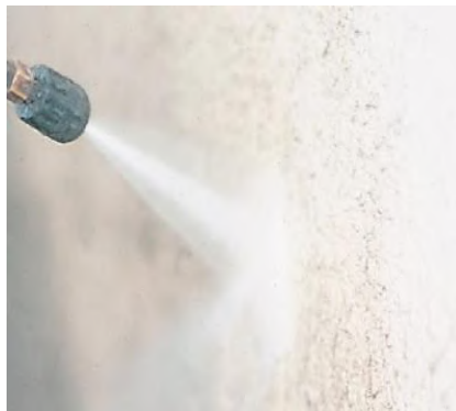
Figura 3.5 – Lavagem com lavadora de alta pressão.
