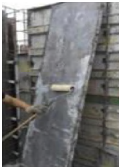
Figura 4.8 – Aplicação de desmoldante nas placas da fôrma.
