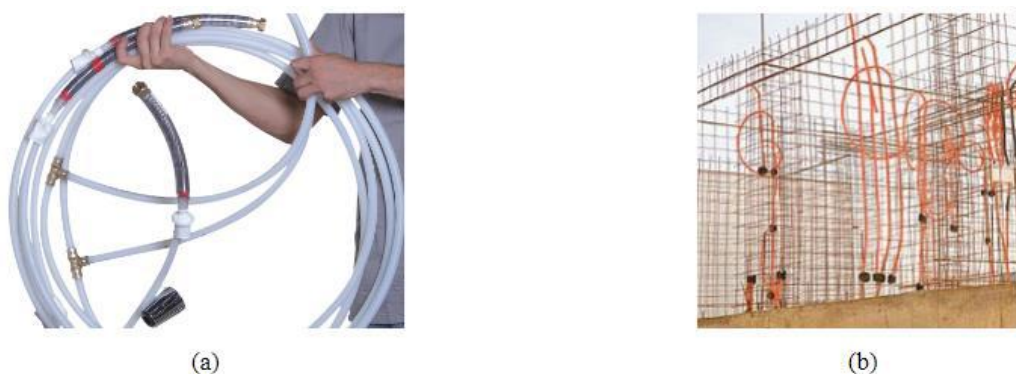
Figura 2.13 – (a) Tubos PEX e (c) Instalações das paredes executadas.
