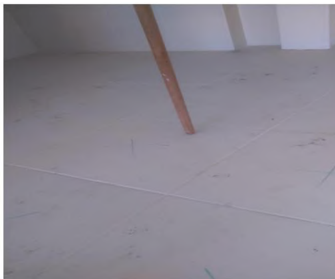
Figura 3.10 – Teste de percussão em revestimento.
