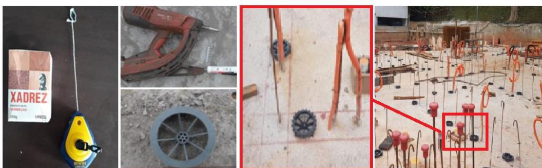
Figura 4.4 – Giz de linha, pó xadrez, pistola finca pino, pinos, distanciador, espaçadores e distanciadores no eixo da fôrma e a marcação completa no piso.
