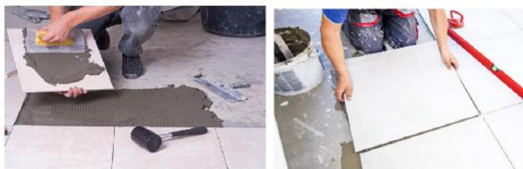
Figura 3.6 – Aplicação de argamassa na peça.
