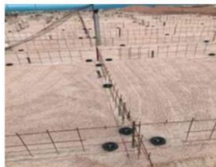
Figura 2.7 – (a) Uso dos espaçadores e (b) Marcação.
