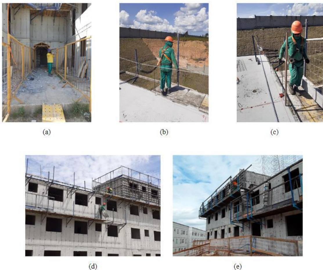
Figura 2.4 – (a) Áreas do entorno e acesso isoladas; (b) Utilização de todos os equipamentos e sistemas de segurança necessários para o trabalho em altura; (c) e (d) Montagem do sistema de segurança das paredes de concreto e (e) Sistema de segurança completo.
