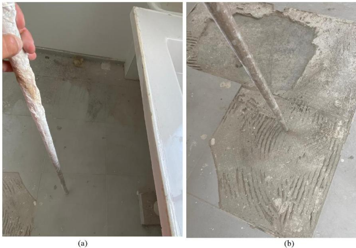
Figura 4.23 – Ensaio de percussão.
