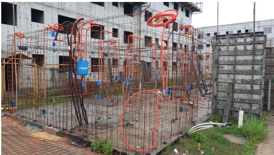
Figura 4.7 – Armação completa das paredes.
