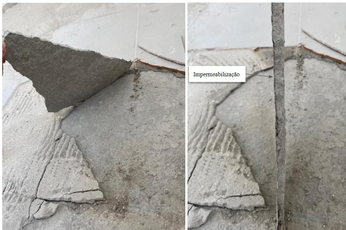
Figura 5.1 – Exemplo de placas que apresentaram deslocamento.
