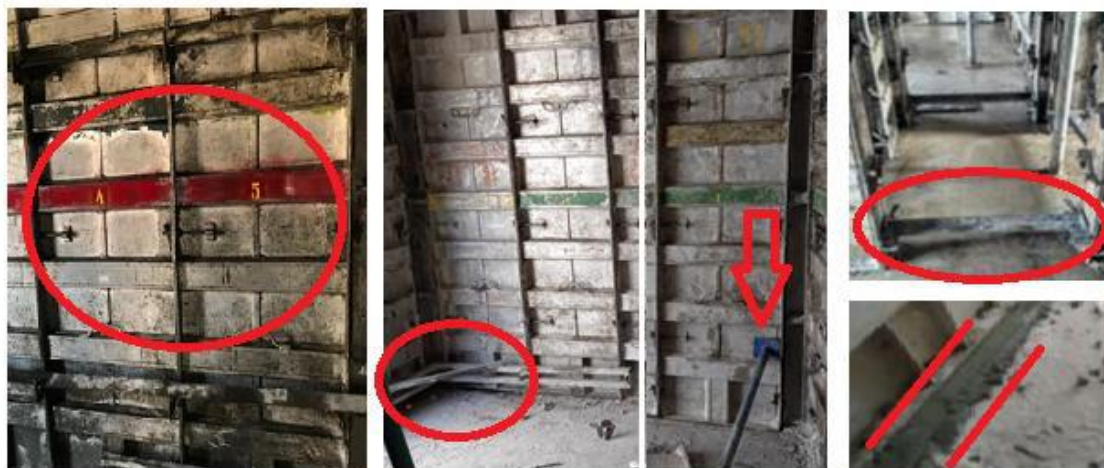
Figura 4.10 – Detalhes de travamentos e escoramentos dos painéis.
