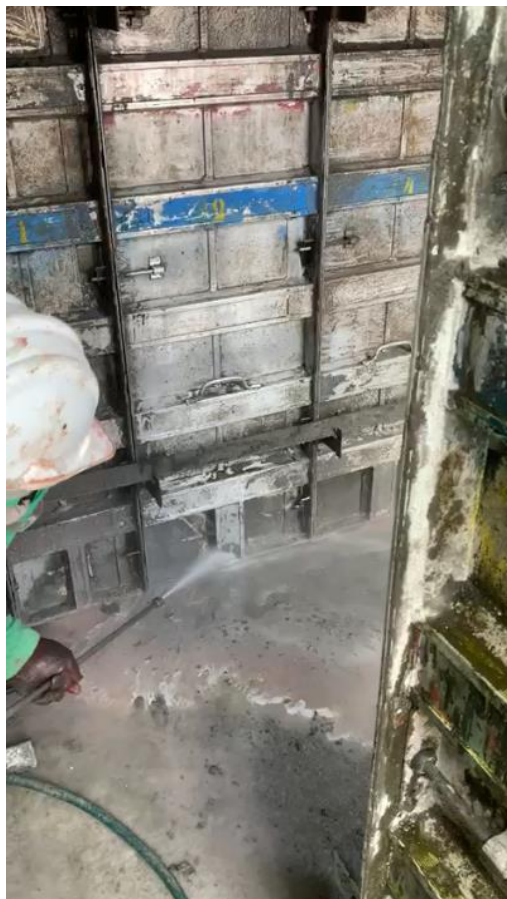
Figura 2.12 – Limpeza das fôrmas.
