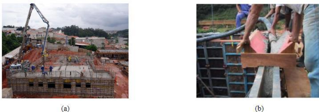
Figura 2.11 – (a) Lançamento do concreto com bomba lança e (b) Lançamento do concreto nas paredes.
