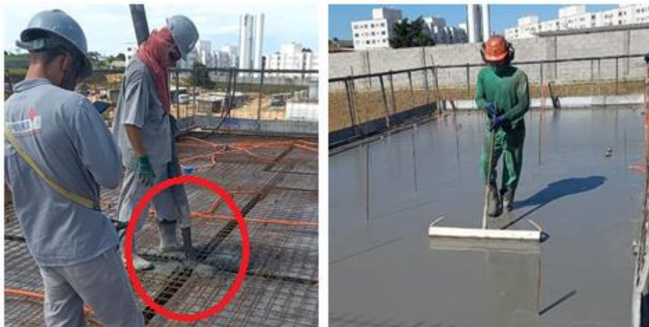
Figura 4.12 – Lançamento de concreto.
