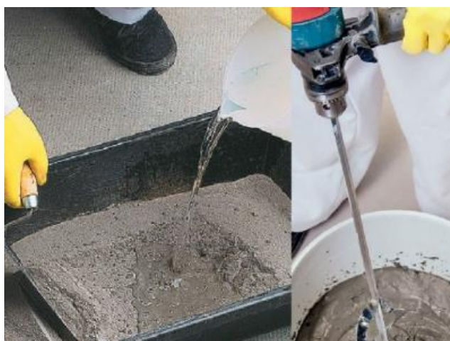
Figura 3.4 – Preparo da argamassa.
