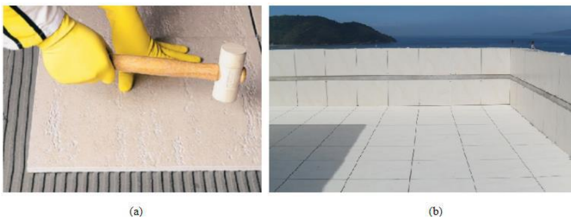
Figura 3.7 – (a) Assentamento do piso e (b) Piso assentado.
