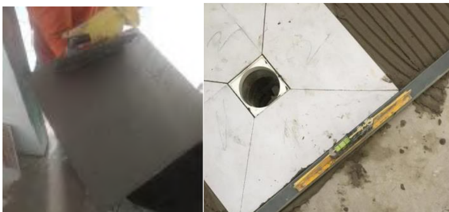
Figura 4.19 – Aplicação de argamassa e detalhe do encontro das cerâmicas com um ralo no banheiro
