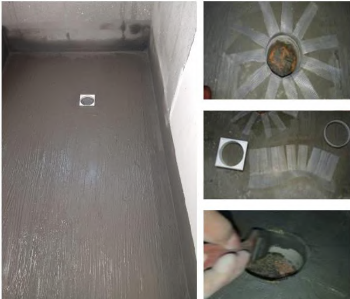
Figura 4.16 – Detalhes da impermeabilização em um dos banheiros.
