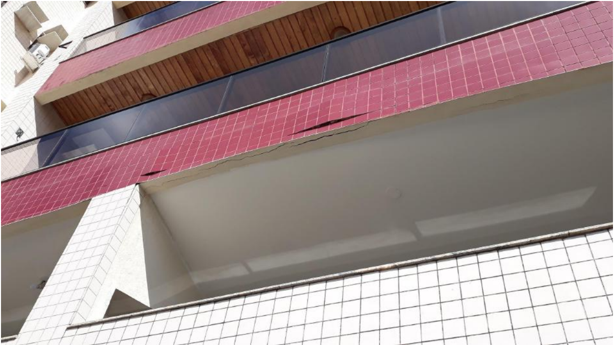
Figura 42 - Estufamento do revestimento (Fonte: Acervo pessoal)
