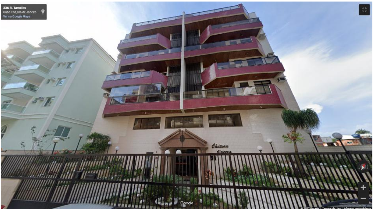
Figura 38 - Perspectiva da edificação 4 (Fonte: Google)
