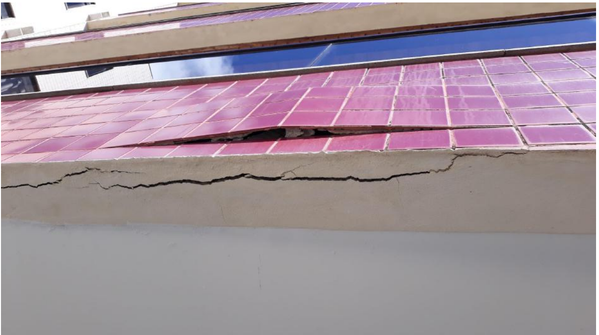
Figura 43 - Estufamento do revestimento (Fonte: Acervo pessoal)
