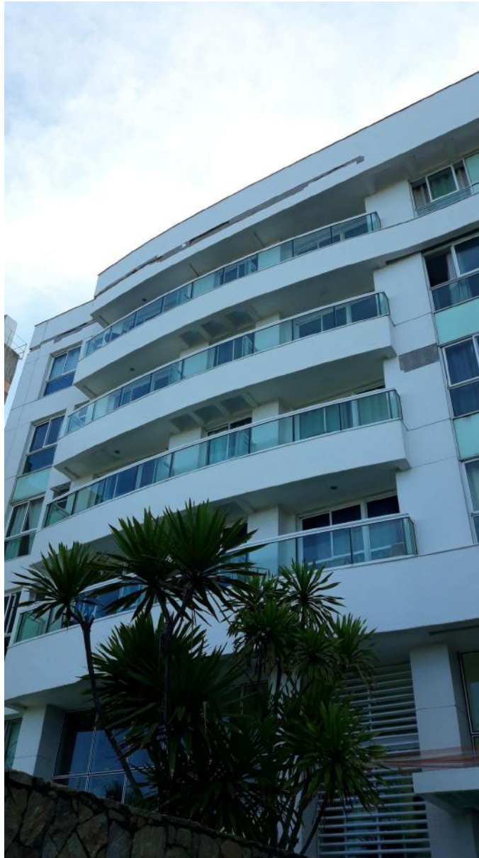
Figura 55 - Fissuração e desprendimento de emboço (Fonte: Acervo Pessoal)
