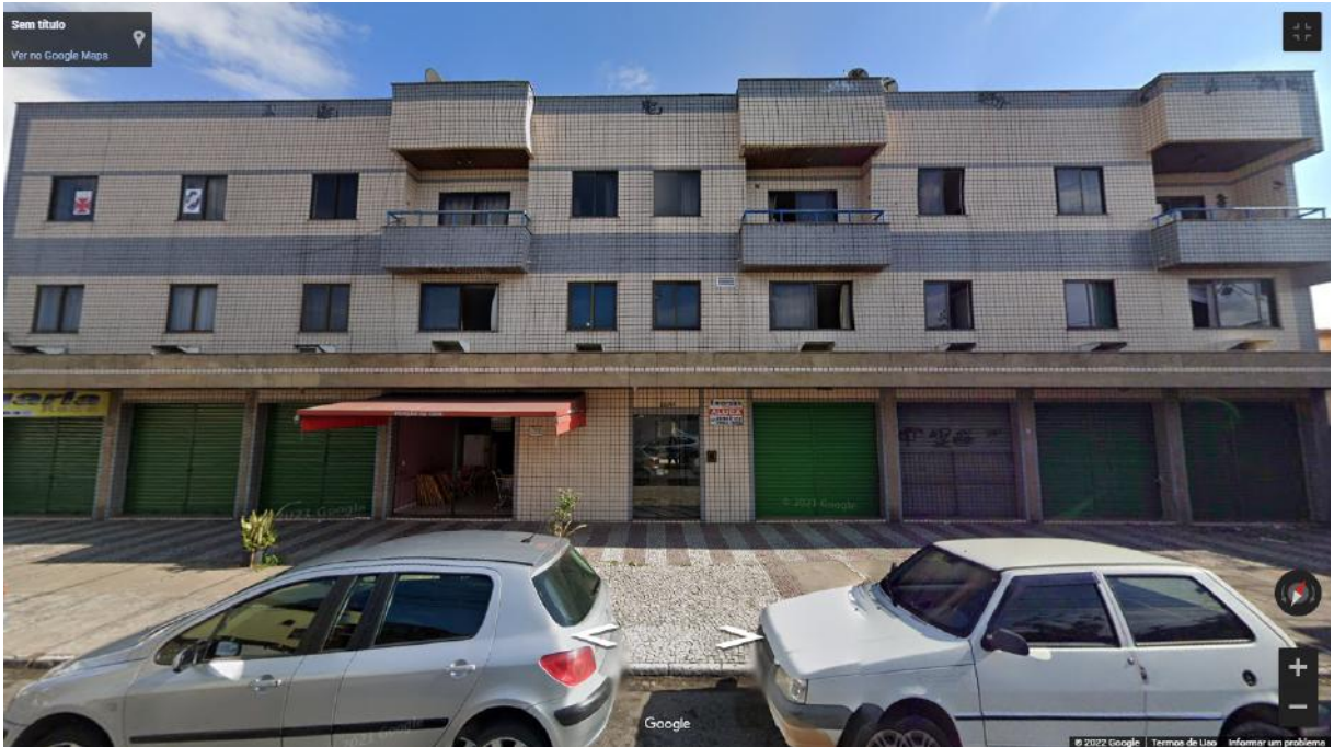
Figura 45 - Fachada frontal da edificação 5 (Fonte: Google)
