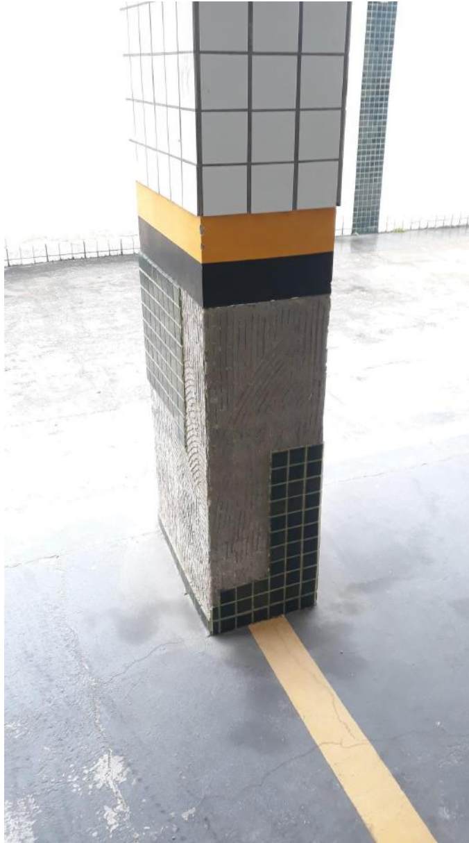
Figura 28 - Destacamentos no térreo (Fonte: Acervo pessoal)
