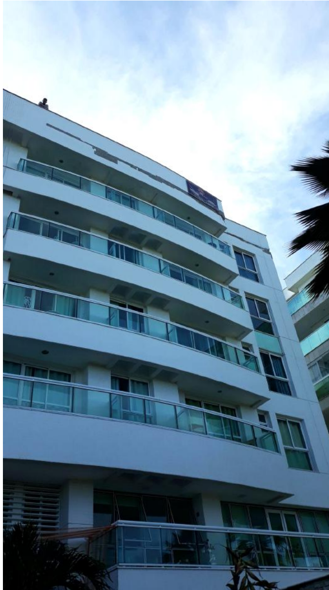
Figura 54 - Retirada de revestimentos (Fonte: Acervo Pessoal)
