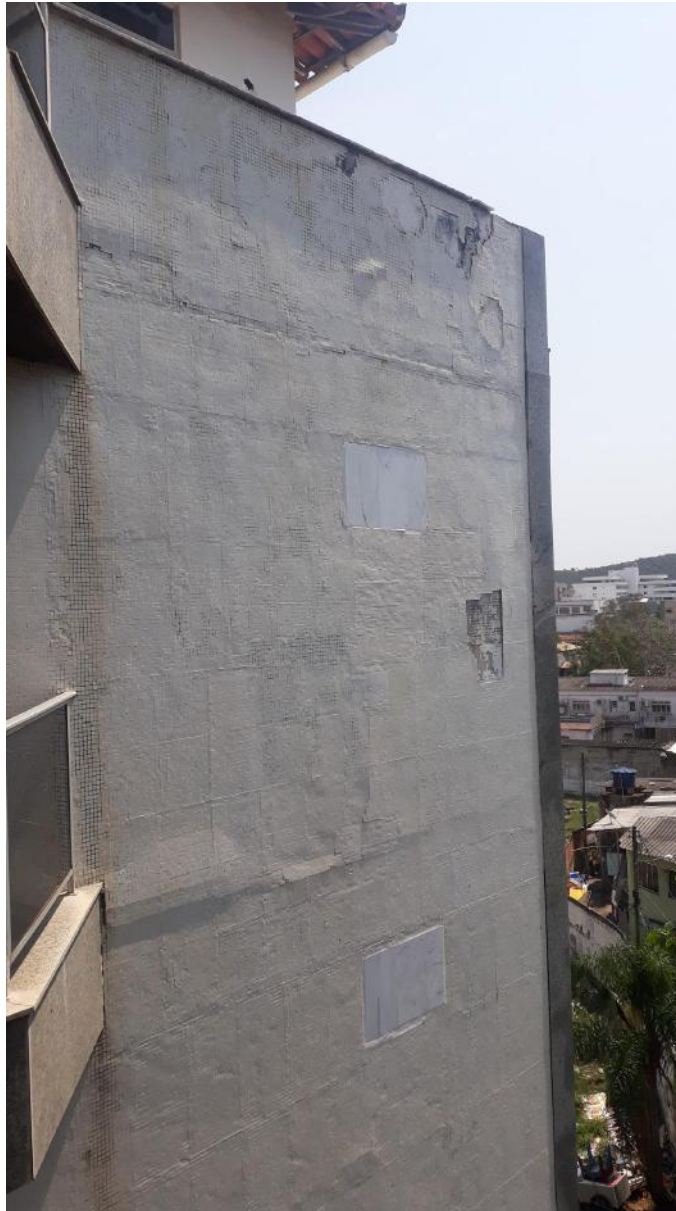
Figura 35 - Estufamento nas divisões dos pavimentos (Fonte: Acervo pessoal)
