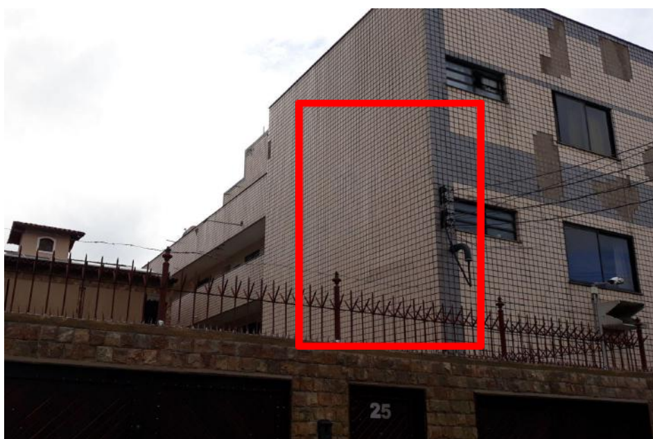
Figura 11 - Estufamento de cerâmicas (Fonte: Acervo pessoal)
