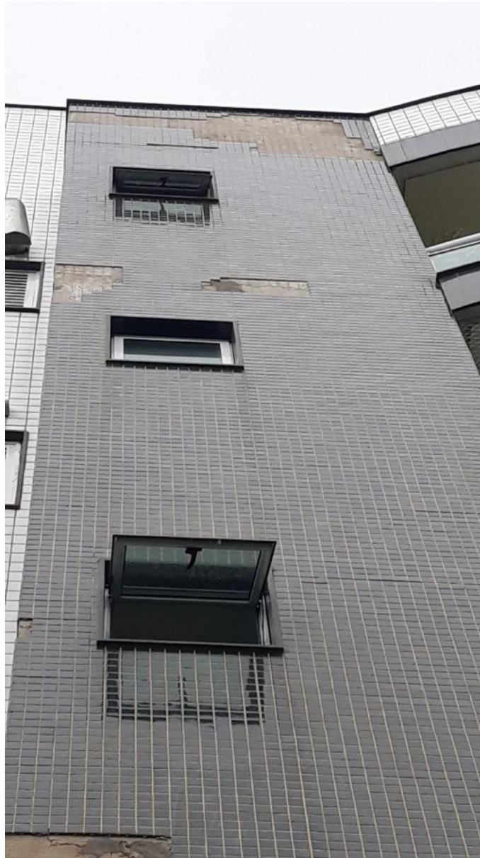
Figura 27 - Destacamentos (Fonte: Acervo pessoal)
