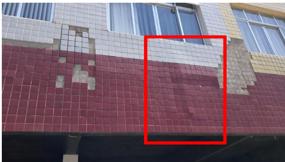
Figura 10 - Estufamento de cerâmicas (Fonte: Acervo pessoal)
