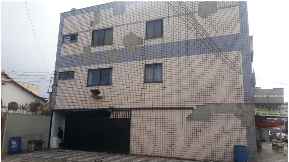
Figura 49 - Retirada do revestimento estufado (Fonte: Acervo pessoal)
