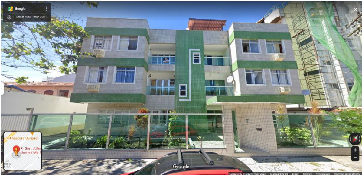
Figura 19 - Fachada frontal do edifício 1
