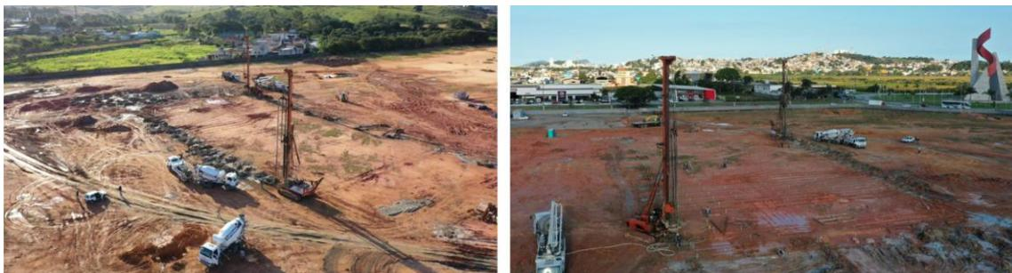
Figura 2.8 -Imagens aéreas de uma grande obra envolvendo estacas hélice contínua monitorada na cidade de Macaé. (cortesia Solo Suporte Fundações)
