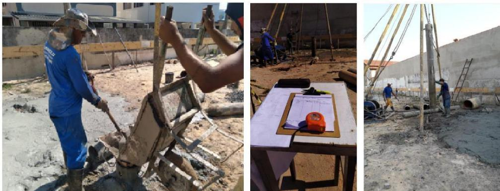
Figura 3.4 - Detalhes das etapas finais da execução da estaca Strauss (autor 2021)
