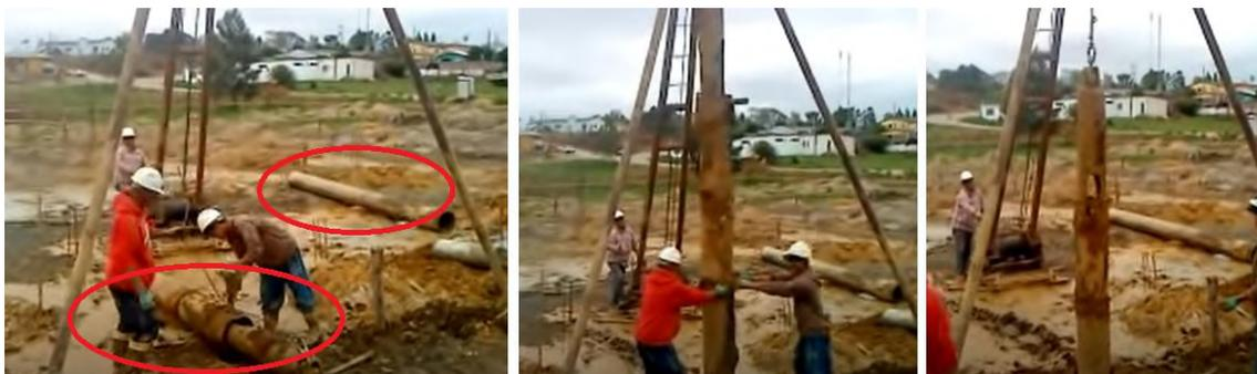
Figura 3.3 - Detalhes da primeira etapa da execução da estaca Strauss, destaque para lama produzida durante a escavação e os equipamentos principais da execução (Guimarães, 2021)
