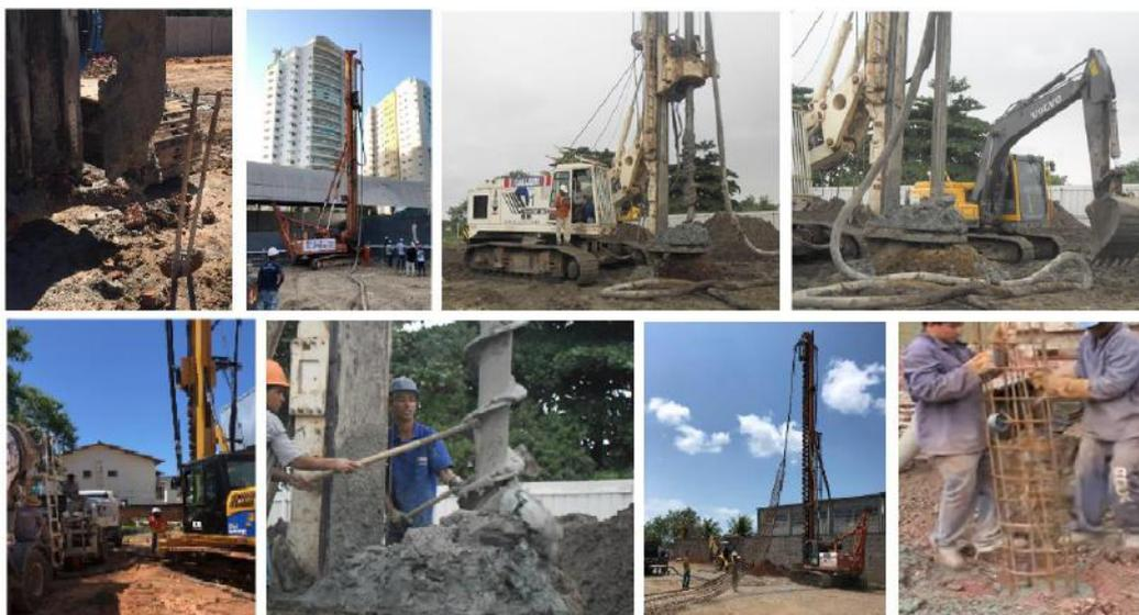
Figura 2.6 - Sequência de execução de uma estaca hélice contínua monitorada (cortesia Solo Suporte Fundações e Guimarães, 2021)
