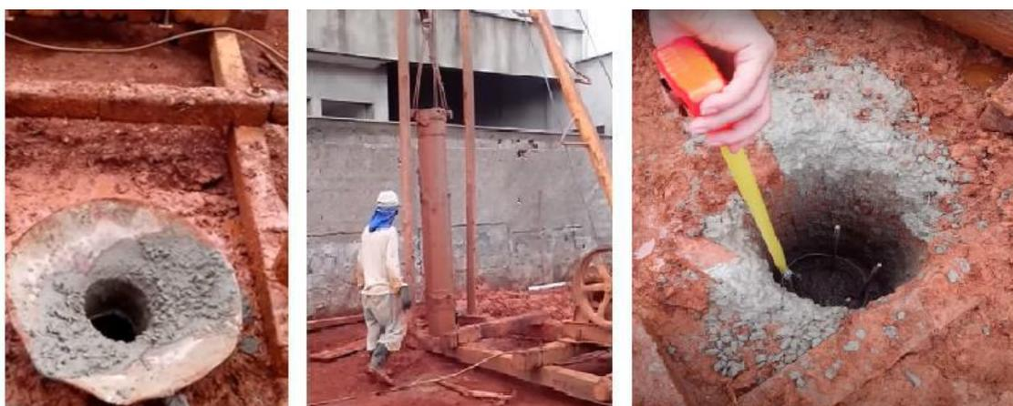
Figura 3.5 - Detalhes das etapas finais da execução da estaca Strauss, com foco na concretagem e posicionamento da armadura (Guimarães, 2021)
