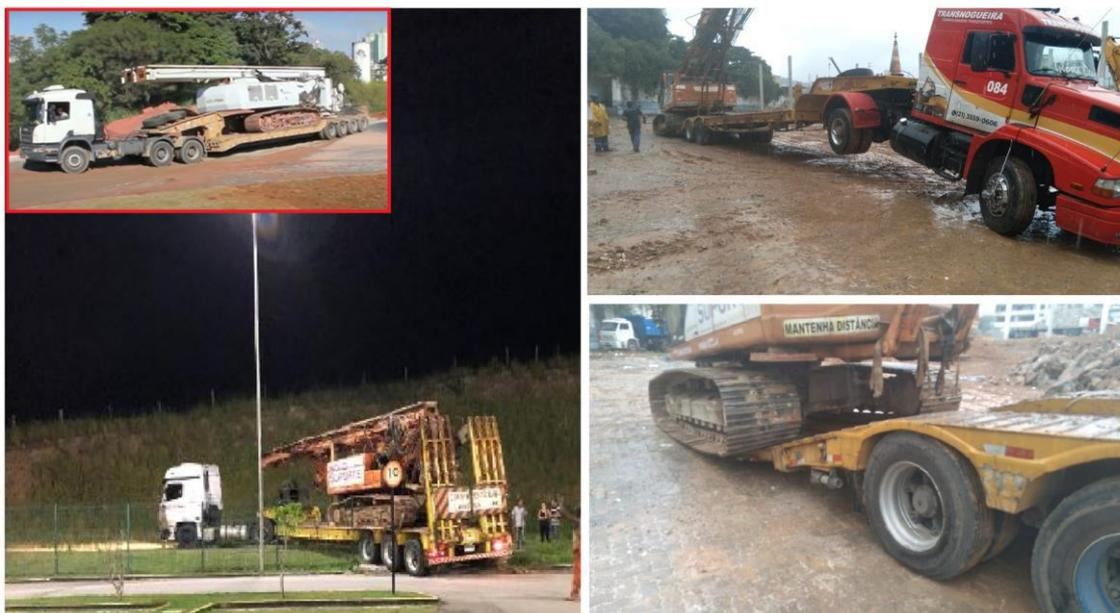
Figura 2.1 - Desafios durante o transporte de uma perfuratriz de estaca hélice contínua monitorada
