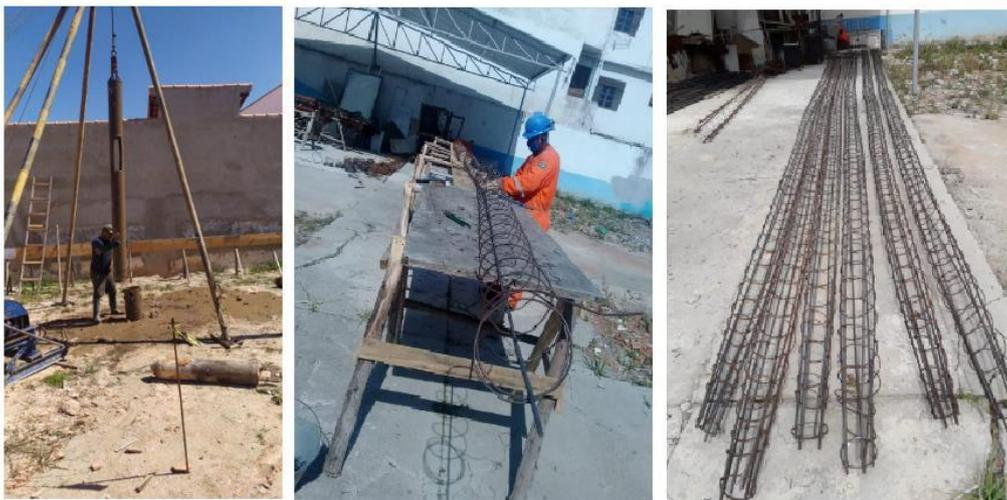
Figura 3.2 - Detalhes da primeira etapa da execução da estaca Strauss, destaque para armadura típica de uma estaca com afunilamento da ponta. (autor 2021)
