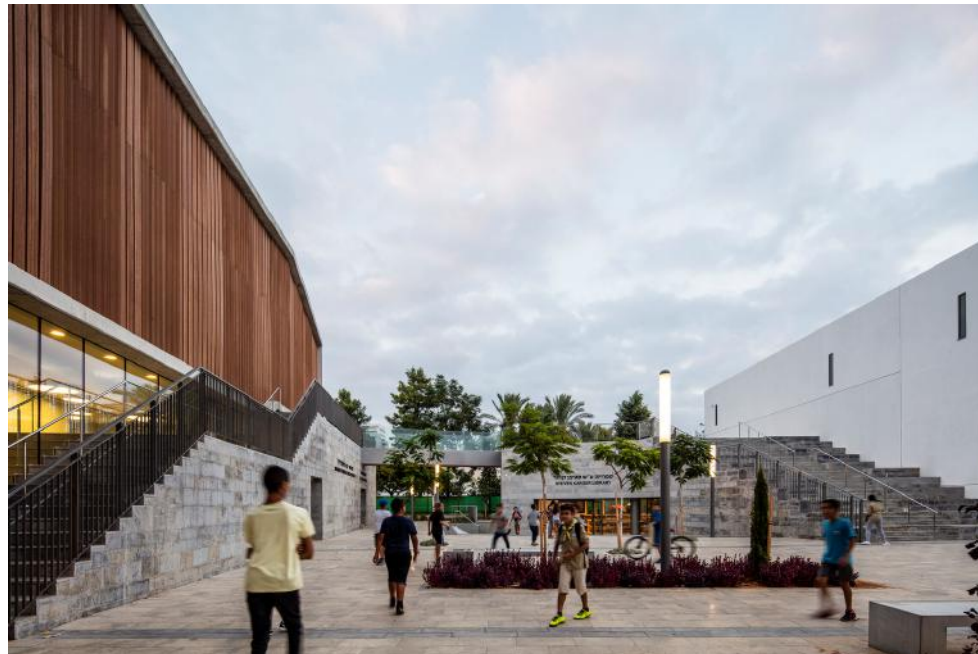
Figura 58: Vista para o Centro Comunitário, mostrando a biblioteca a direita e o Centro Comunitário a esquerda, com a passarela conectando-os. Fonte: Archdaily.
