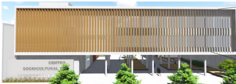
Figura 94: Imagem da fachada Sudeste do prédio de Capacitação, onde é usado brise vertical. Fonte: Autoral.
