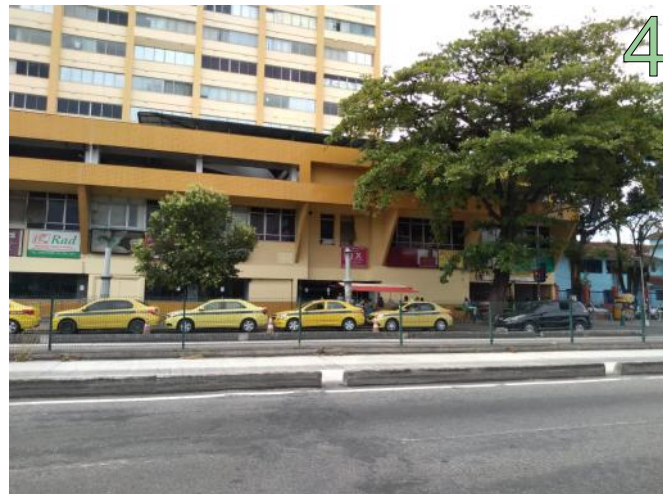
Figura 31: Vista prédio comercial em frente ao terreno. Fonte: Autoral.
