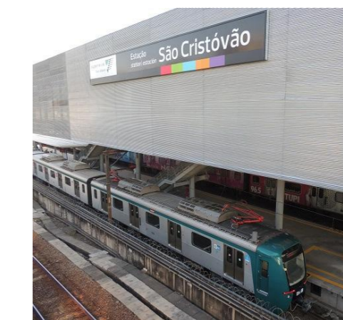
Fig.29. Estação São Cristóvão, 2019. Fonte: SuperVia entrega estação São Cristóvão totalmente reformada. Disponível em: https://anprilhos.org.br/ . Acesso em: Outubro 2019
