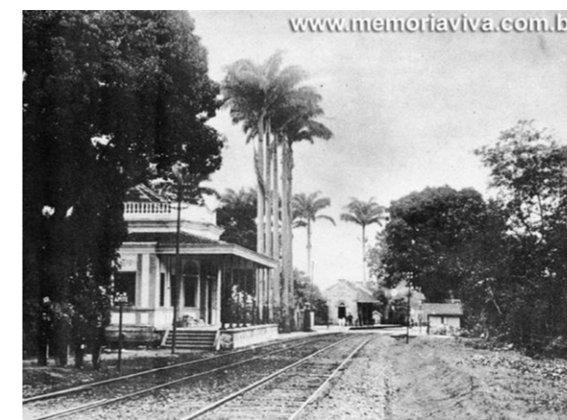
Fig.28. A antiga estação da Quinta Imperial (depois Quinta da Boa Vista), construída para uso exclusivo do Imperador e sua família. Foi concluída a 16 de julho de 1859. Fonte: Memória Viva
