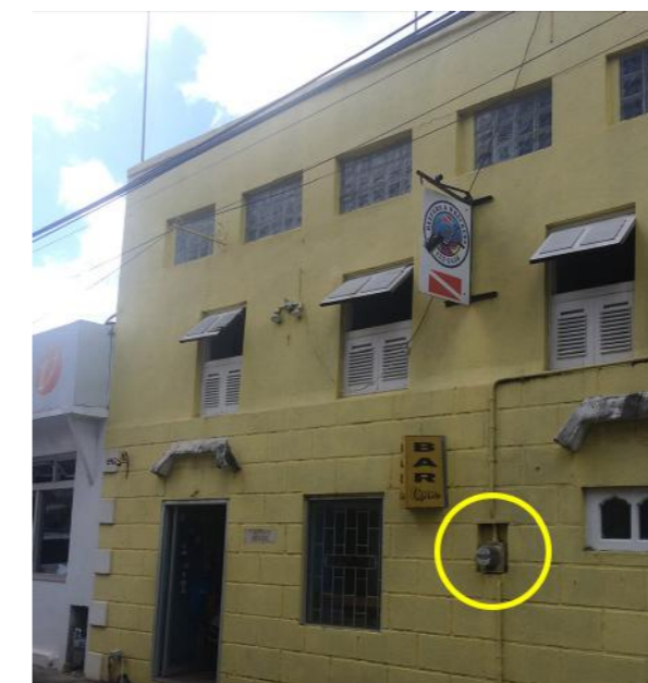
Figura 7.35. Exemplo da utilidade exposta no edifício.
