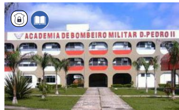
Figura 23 Academia de Bombeiros e Corpo de Bombeiros - Raio de 1200m Fonte: Google Imagens
