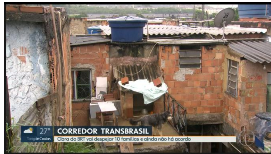
Figura 18 Algumas das casas que serão removidas. Fonte: : GloboPlay, 2019
