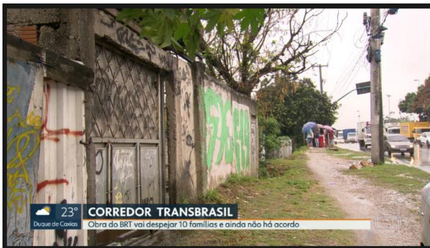
Figura 19 Algumas das casas que serão removidas a margem da Avenida Brasil. Fonte: : GloboPlay, 2019
