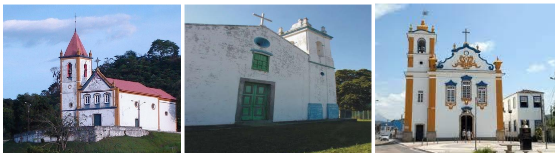
Na seqüência: Igreja de S. Nicolau de Sururuí (1628), Igreja de N. S. da Guia de Pacobaíba (1647) e Igreja de N.S. da Piedade e Magé (1650).
