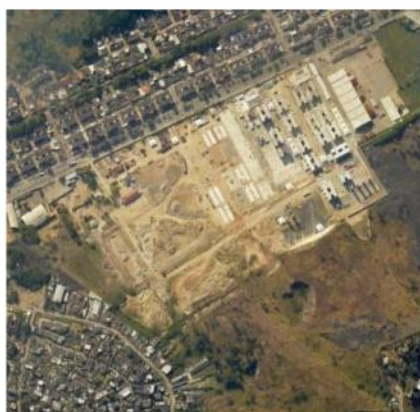
Figura 14: Condomínio Reserva Solare sendo construído em antigo lote industrial. Fonte: Google Earth, 2019.
