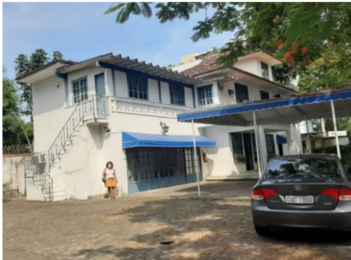
Figura: 14 Casa de apoio
