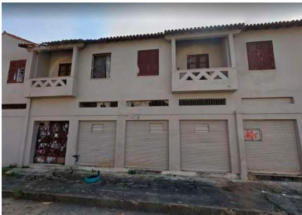
Foto da fachada na Travessa Etelvina vãos do forro ventilado obstruído, esquadria de ferro oxidada e esquadrias danificadas e faltantes
