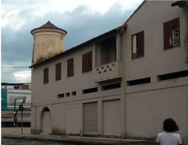
Foto da fachada na Travessa Etelvina onde podemos observar diversos vãos vedados e esquadrias danificadas. Ao fundo observa-se mancha de umidade na torre
