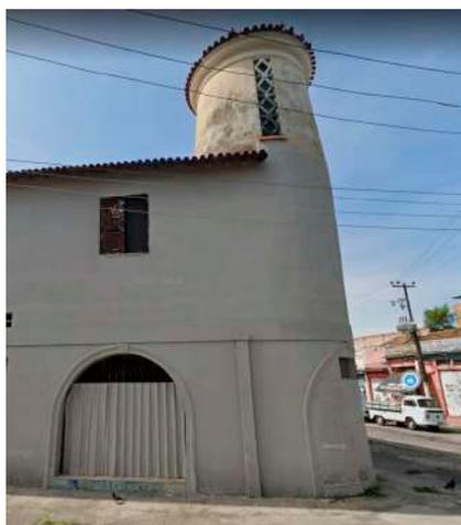
Foto da torre na esquina da Uranos com Travessa Etelvina. Vemos o acesso principal ao edifício vedado, torre com pintura danificada e esquadria danificada
