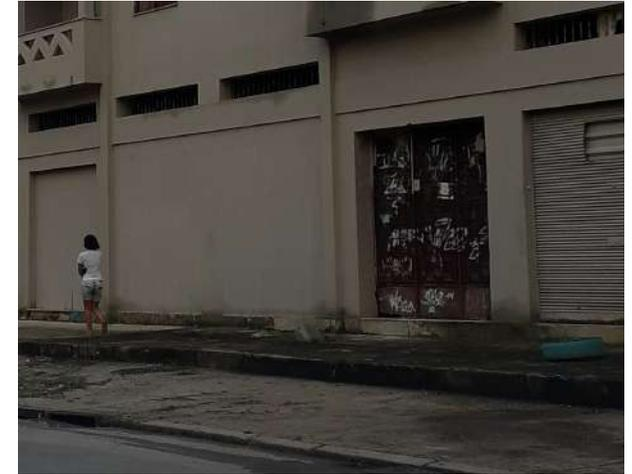
Foto fachada Travessa Etelvina onde observa-se guarda corpo com manchas de umidade, telhas danificadas, portão em ferro oxidado
