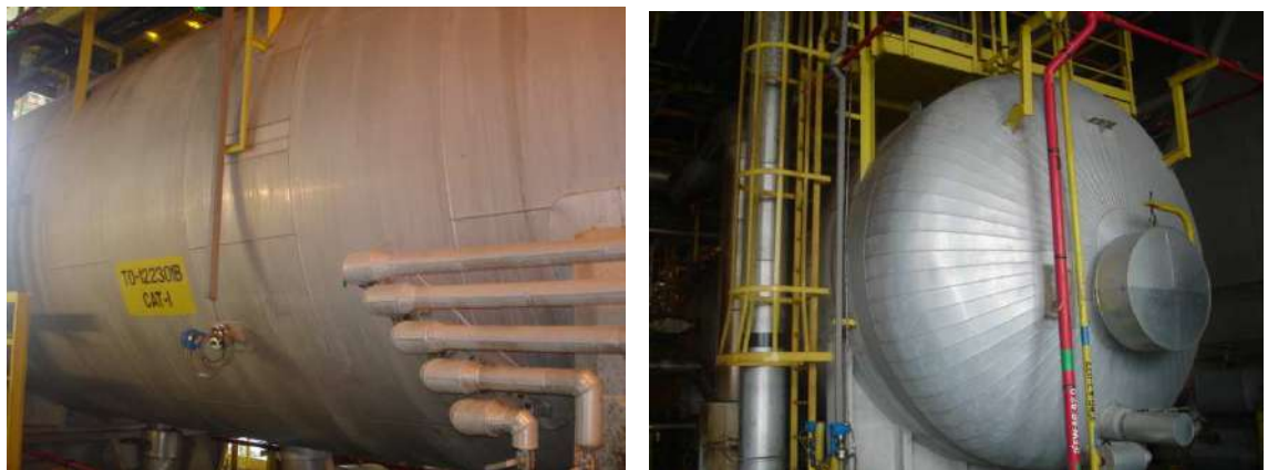
Figura 2-12: Foto do tratador eletrostático de uma plataforma na Bacia de Campos.
