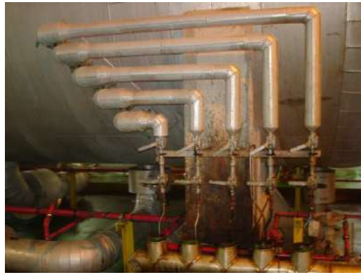
Figura 2-13: Foto dos pontos de amostragem do tratador eletrostático Dual Polarity da Bacia de Campos.
