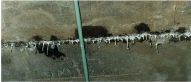
**Figura 10:** Lixiviação com formação de estalactites (GENTIL, 2007)
