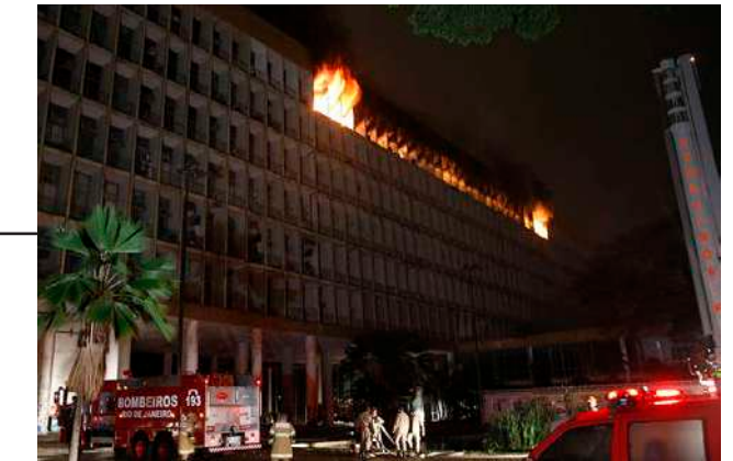
Incêndio nos pavimentos superiores do Bloco A ocupados pela Reitoria, Escola de Belas Artes e IPPUR.
