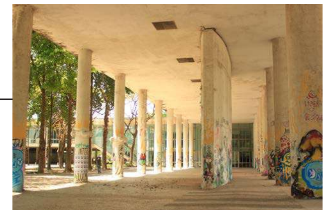
Os pilotis e o antigo acesso principal ao edifício.
