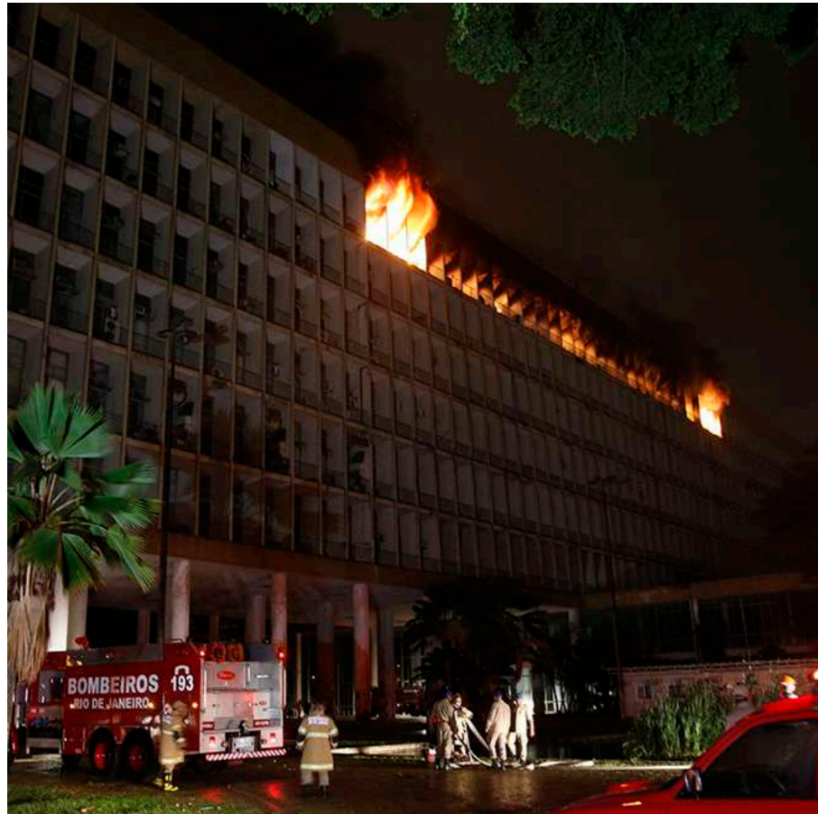
Incêndio nos pavimentos superiores do Bloco A ocupados pela Reitoria, Escola de Belas Artes e IPPUR. Fonte: Jornal "O Globo".
