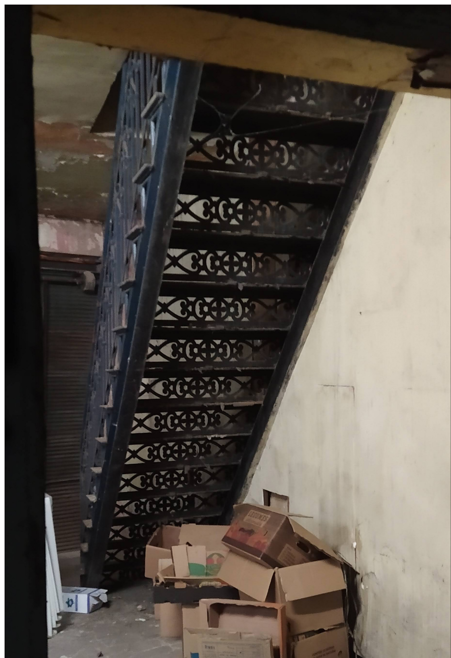
Cinema Oriente. Escada em ferro fundido Foto:2020. Acervo pessoal.
