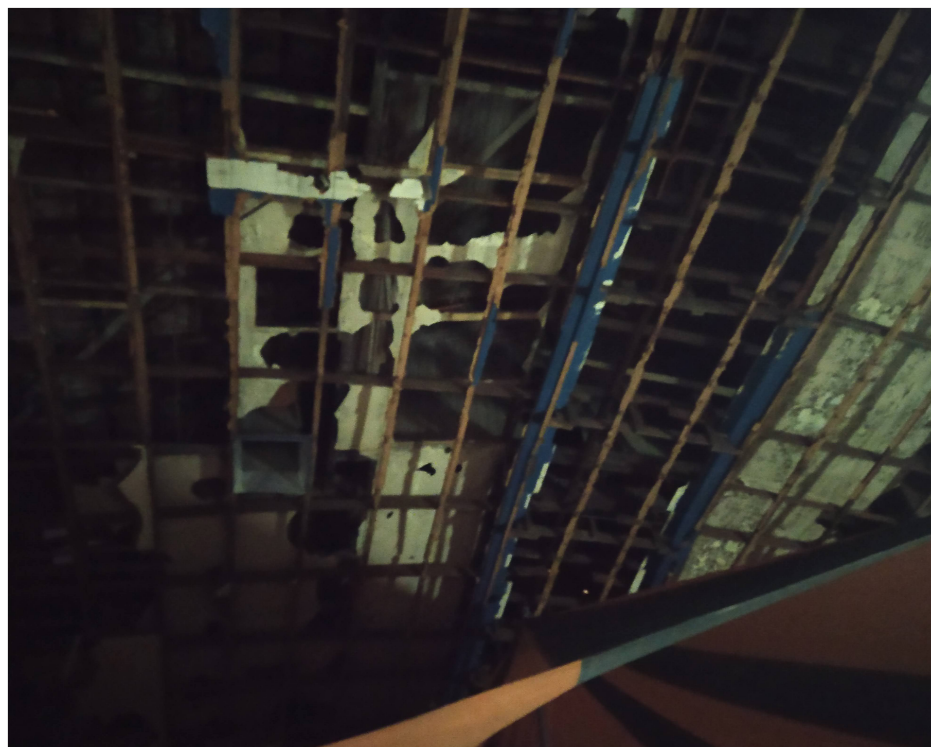
Cinema Oriente. Forro de madeira. Foto: Acervo pessoal,2020.
