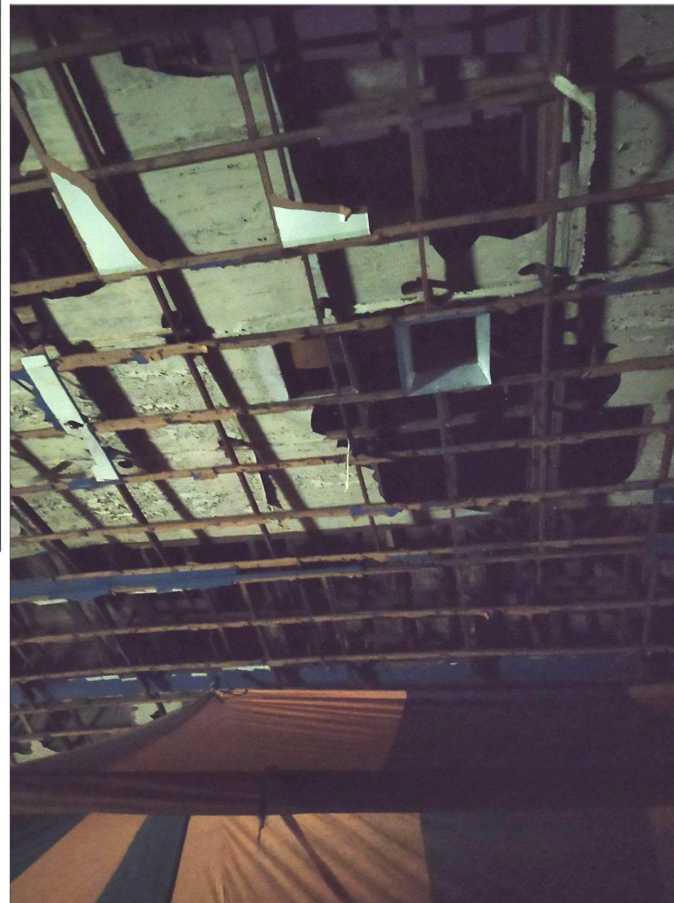
Cinema Oriente. Forro de madeira. Foto: Acervo pessoal,2020.
