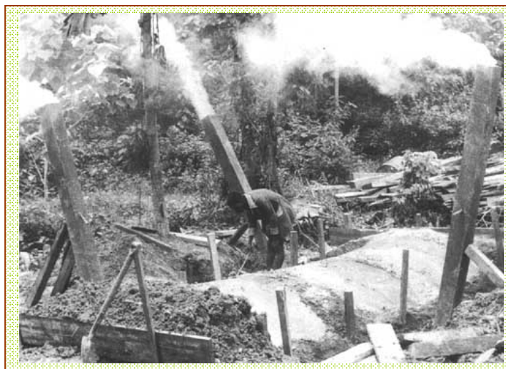
Figura 4.2– Caieira em Gana (África) durante a queima de lenha, modificada em com chaminés e cobertura metálica, entre estacas de madeira e rejantes de terra (FAO, 1987 – Fotografia de Lejeune)
