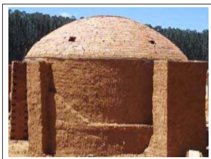
Figura 4.23 – Forno Colméia de Superfície com chaminé (Bastos Filho, 2008)
