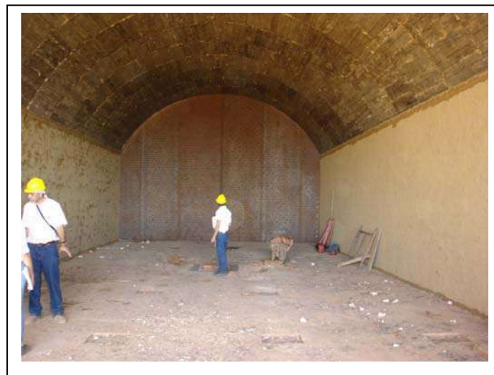
Figura 4.35 – Etapas da construção de um forno retangular de concreto armado (Brito, 2008)
