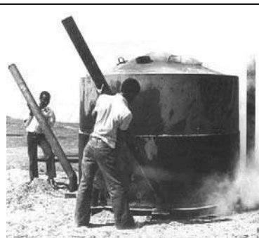
F - Montagem das chaminés e preenchimento dos espaços entre os canais de entrada de ar e de saída de gases com areia ou solo
