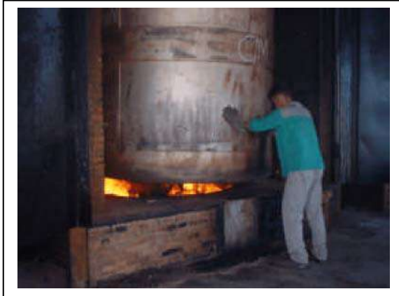
Figura 5.29 – Entrada do cilindro metálico sobre a base do forno de carbonização com ticos em combustão (Bricarbras, 2006)
