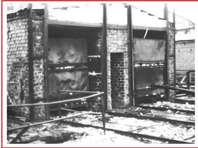
Figura 6.13 – Estufa de pré-secagem de madeira da unidade de processo da retorta de vagões (FAO, 1985)
