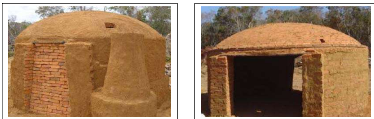
Figura 4.25 – Forno JG com duas portas, diâm. 3,80m e diâm. 5,10 m x alt 1,6 m adotados pela JB CARBON e outras empresas (Bastos Filho, 2008)
