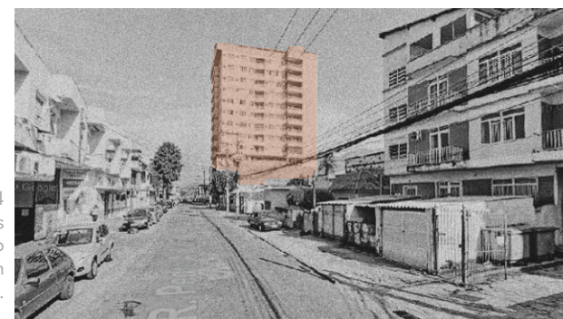
Figuras 12, 13 e 14 Exemplos de novos edifícios e o processo de verticalização em curso em Nilópolis. Fotos: Google Earth.
