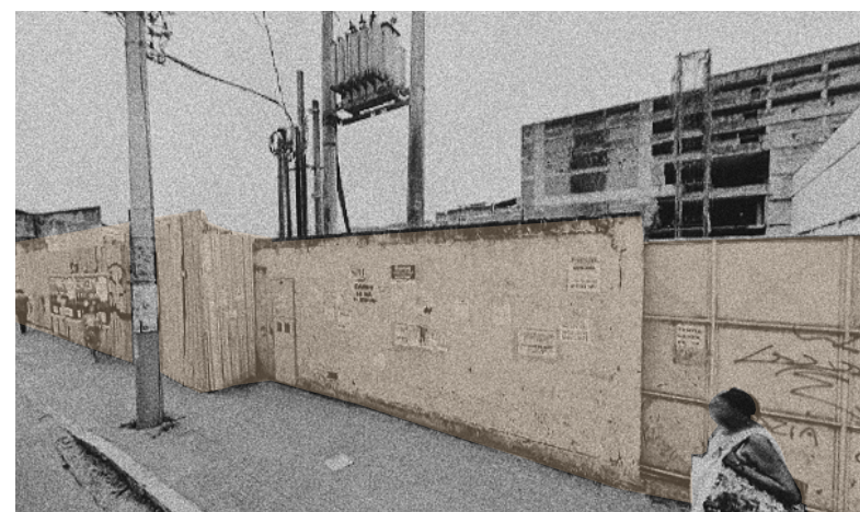
Figuras 27 e 28 Visadas do lote ocioso, atualmente bloqueado, e a edificação aos fundos. Fotos: Google Earth.
