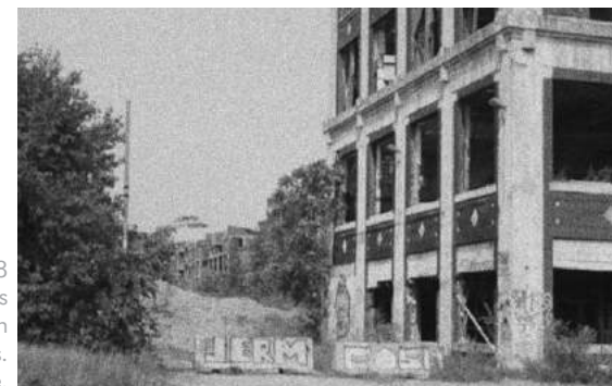
Figura 8 Fábrica de automóveis abandonada em Detroit, Estados Unidos. Foto: Albert Duce.
