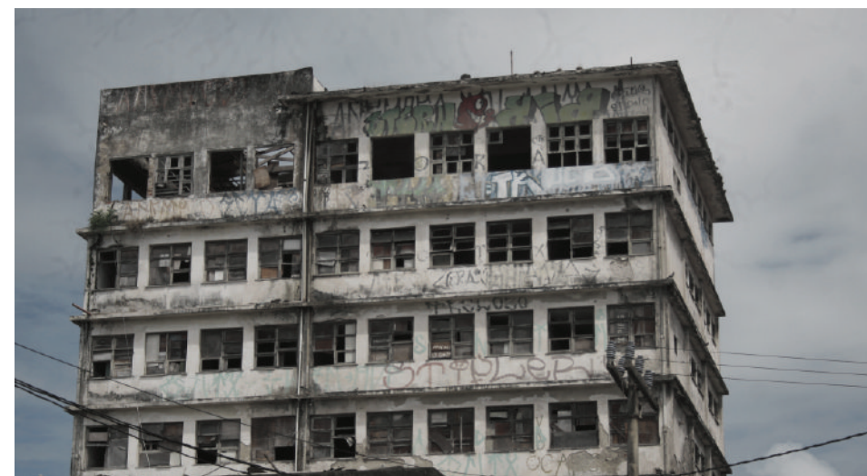
EDIFÍCIO ABANDONADO NO CAIS DE SANTA RITA, RECIFE (PE) (2012)
