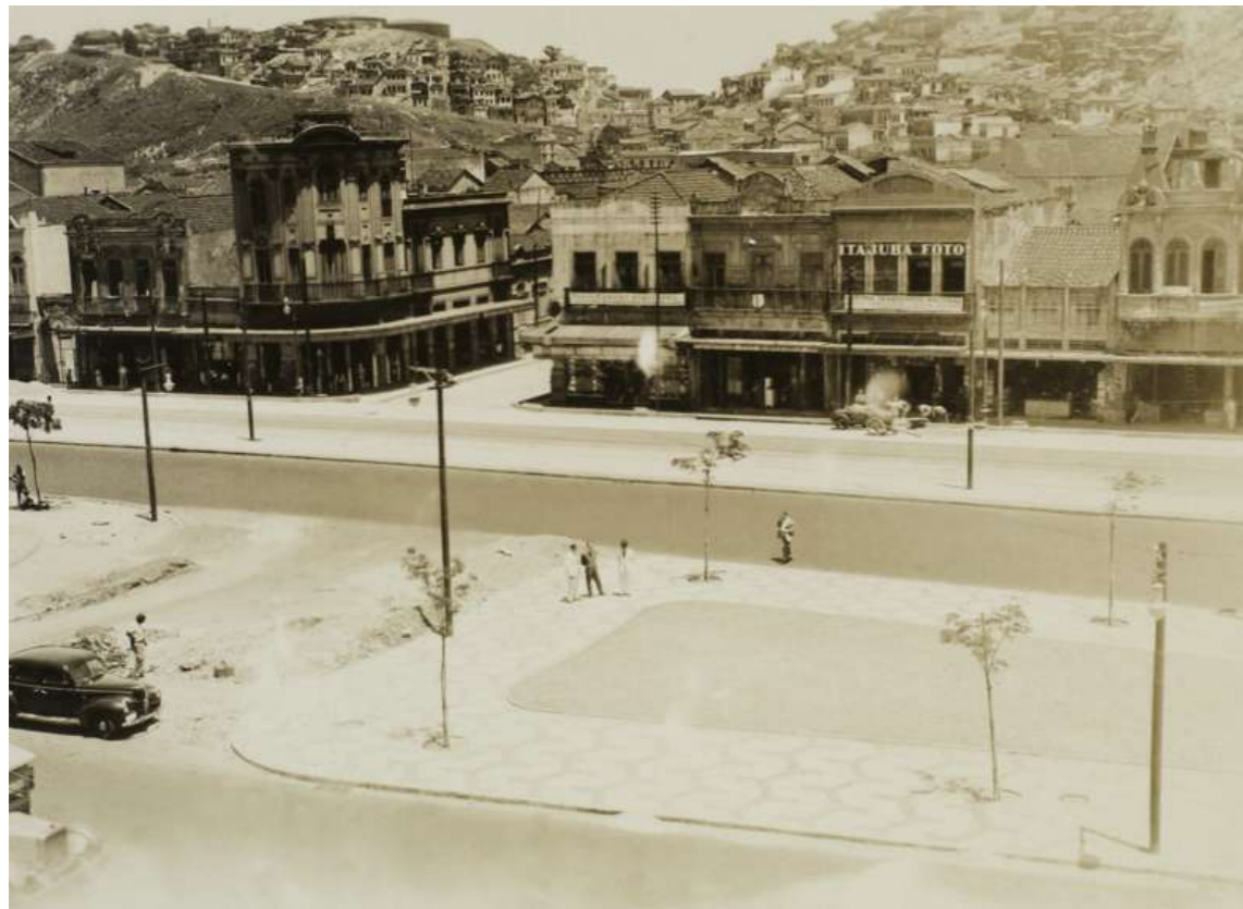
FIG.17 (esq.) Hélio Brito, Obras da Av. Presidente Vargas (ca. 1940)
