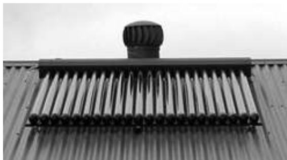
Figura 6 - Coletor Solar de Tubos a Vácuo (adaptado de ENVIRO-FRIENDLY, 2005).
