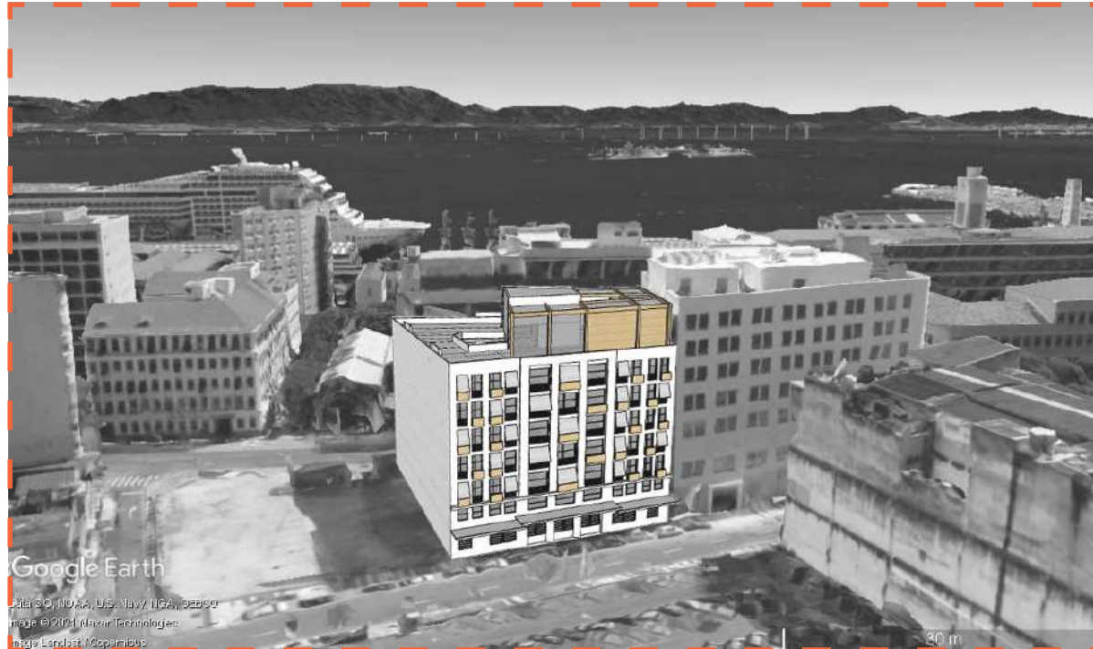
fachada da Rua Coelho e Castro
