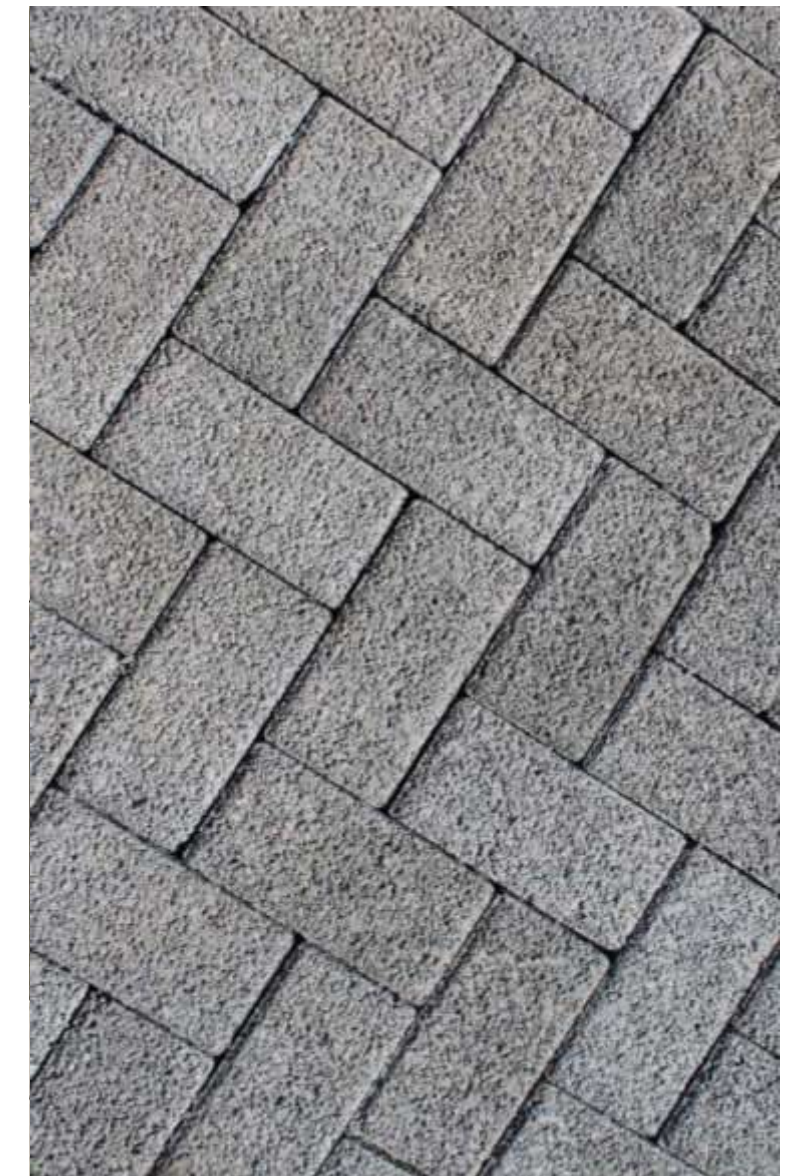
piso de concreto auto drenante
