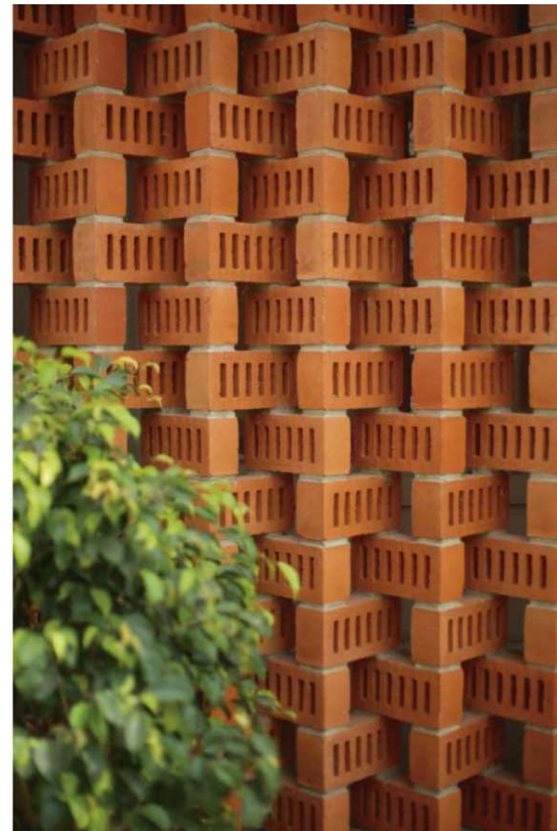
muros da escola são moldados com tijolos na diagonal e intertravados
