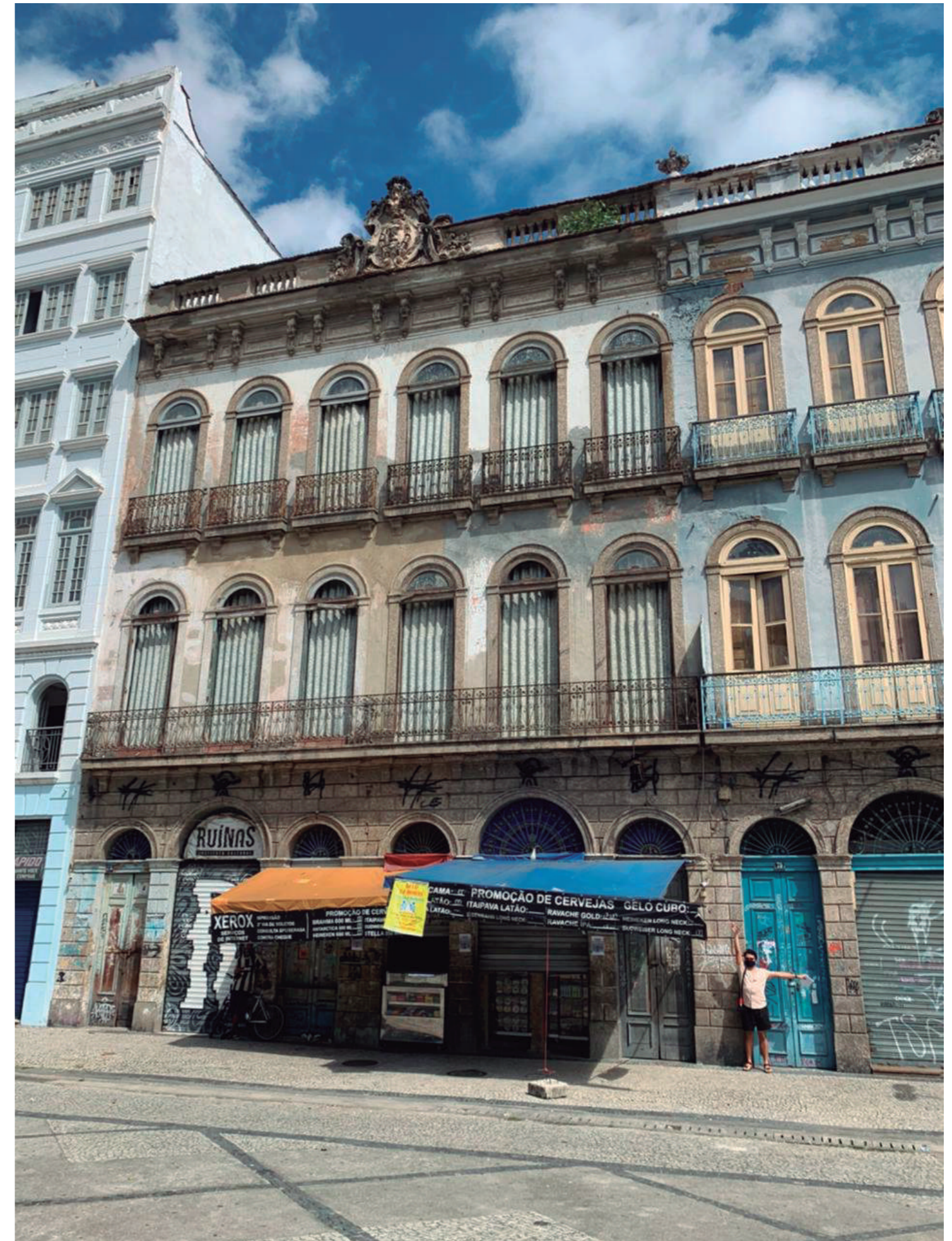
Edifício 75 - Visita realizada em Abril de 2021
