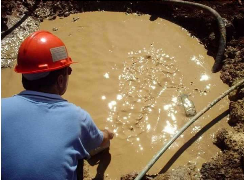
Figura 2- Fluido de perfuração retornando a superfície. Fonte: Planetseed
