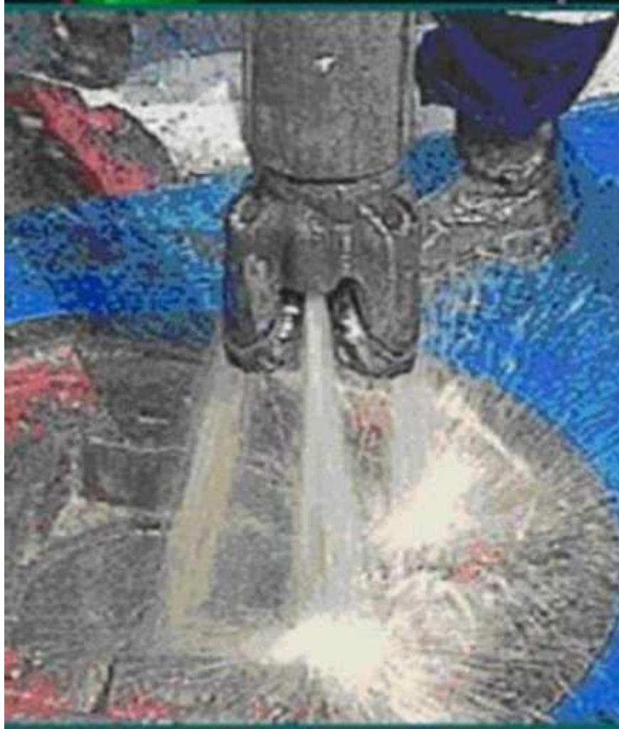
Figura 8- Fluidos de perfuração sob alta pressão. Fonte: SCHAFFEL
