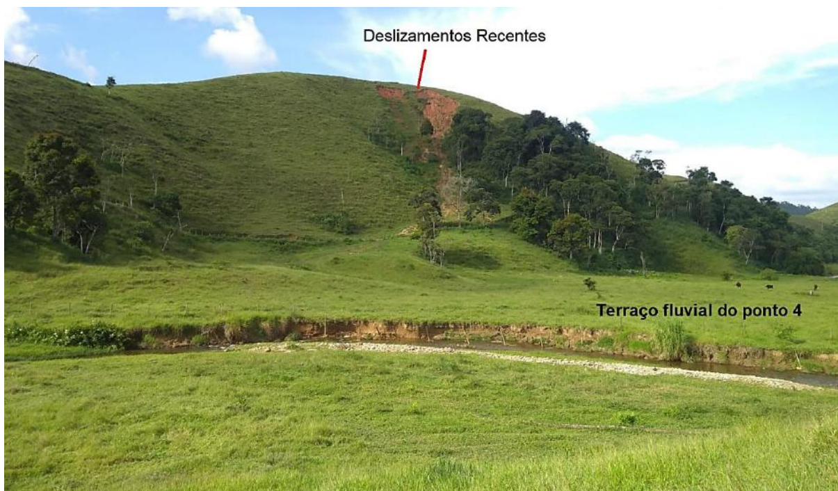
Figura 30: Deslizamento de janeiro de 2022 próximo ao terraço fluvial do ponto 4.
