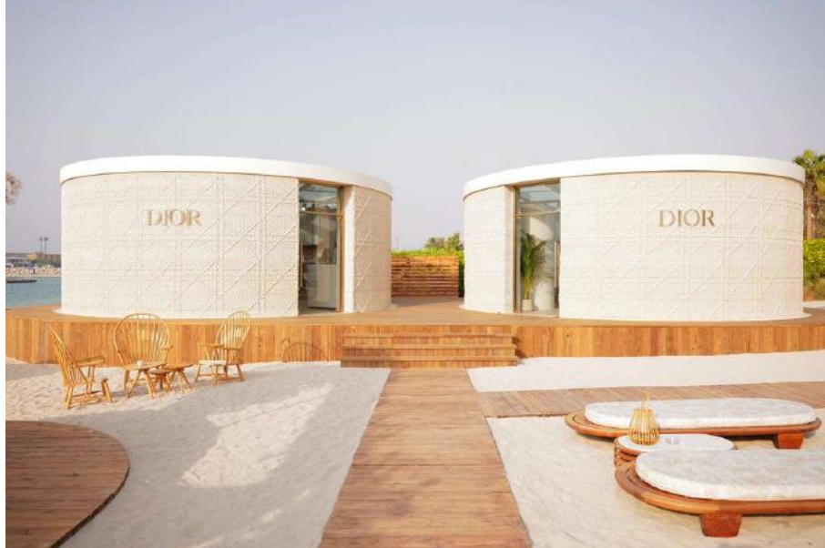
Figura 7- Lojas temporárias da Dior construídas com impressão 3D na exposição de Dubai
