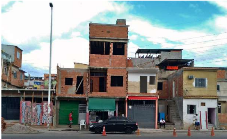
Imagem 104: Autoconstrução, Manguinhos Fonte: Acervo próprio (2019)
