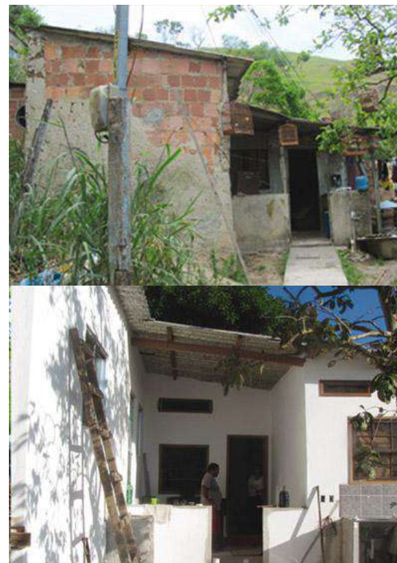
Imagens 22 e 23: Fotos de obra realizada pela ONG Fonte: http://www.solucoesurbanas.org.br/arquiteto-de-familia/fotos
