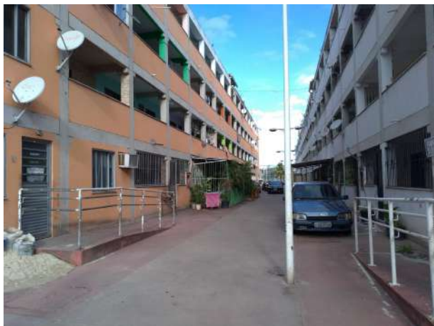
Imagem 8: Conjuntos habitacionais em Manguinhos, Rio de Janeiro, RJ. Obra realizada pelo PAC Fonte: Acervo próprio (2019)
