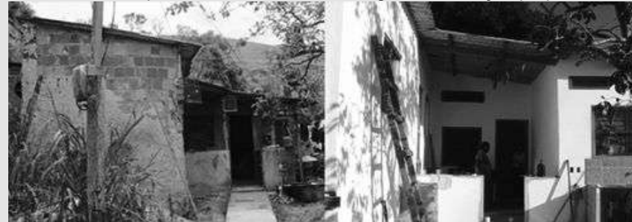
Fotos de obra realizada pela ONG
