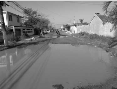
4 Rua totalmente alagada mesmo após dias sem chuva Fonte: Acervo próprio (2021)
