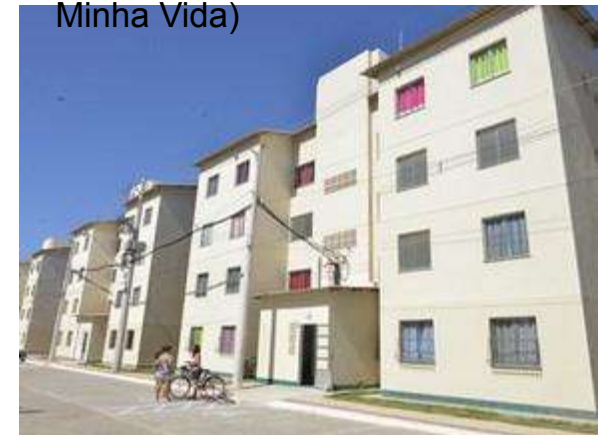
Imagem 9: Residencial Vila Velha Minha Casa, Minha Vida, ES Fonte: http://g1.globo.com/espirito-santo/noticia/2015/05/obra-do-minha-casa-minha-vida-tem-infiltracoes-e-rachaduras-no-es.html
