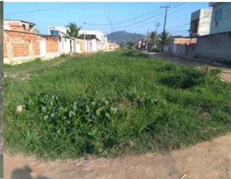
1 Valão totalmente ocupado por vegetação Fonte: Acervo próprio (2021)
