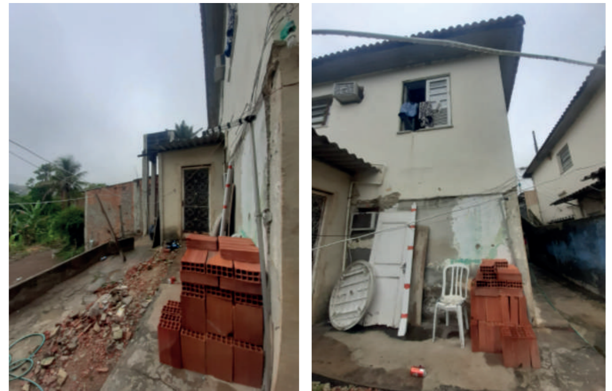
Imagem 73: Entrada para a cozinha da residência, 2021. Imagem 74: Fundos da casa, 2021. Fonte: fotos tiradas gentilmente pela família e cedidas para o trabalho.
