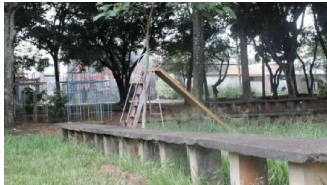
FIGURA 42 – CONDIÇÃO TÍPICA DE EQUIPAMENTOS EXISTENTES (FONTE: FOTO AUTORAL)
