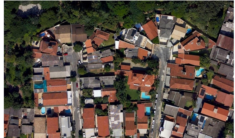
FIGURA 14 – SISTEMA CUL-DE-SAC NO SETOR SUL (FONTE: GOOGLE EARTH)
