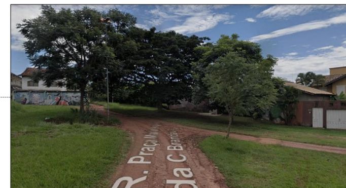
FIGURA 38 – CAMINHO SEM QUALQUER TIPO DE PAVIMENTAÇÃO (FONTE: GOOGLE EARTH)
