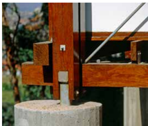
detalhe da junta concreto/metal/ madeira da sapata da residência Hélio Olga, de Marcos Acayaba | nelson kon
