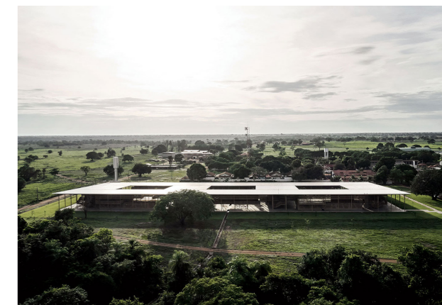
a cobertura massiva vista de cima | critobal palma
