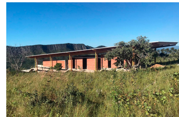
a estrutura de mlc e a cobertura metálica - leve - em contraste com o tijolo - pesado. o fato dos dois não se tocarem enfatiza o contraste 1. vista do pátio das moradias infantis de canuanã 2. casa palicourea do escritório BLOCO | 1. leonardo finotti 2. fotografia da obra disponível no site do escritório BLOCO
