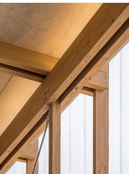
vigas duplas e como elas se conectam aos pilares | fernando guerra
