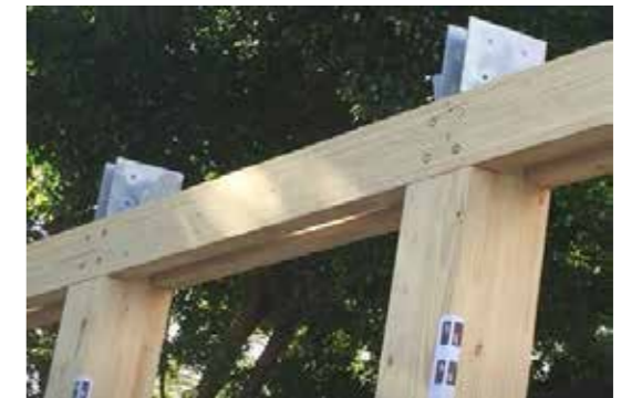
conectores metálicos que ficam no interior da estrutura | foto da obra - carpinteria
