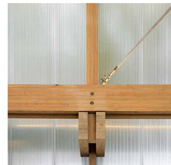
subestrutura de MLC que sustenta as fachadas | fernando guerra
