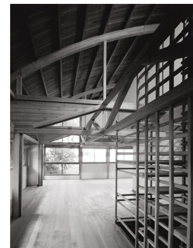
vista da sala com a cobertura curva de MLP e a estrutura da escada à direita | a. pappalardo
