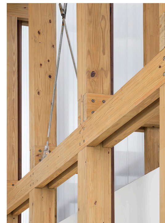
os encontros pilares e vigas parecem serem puramente de madeira | fernando guerra
