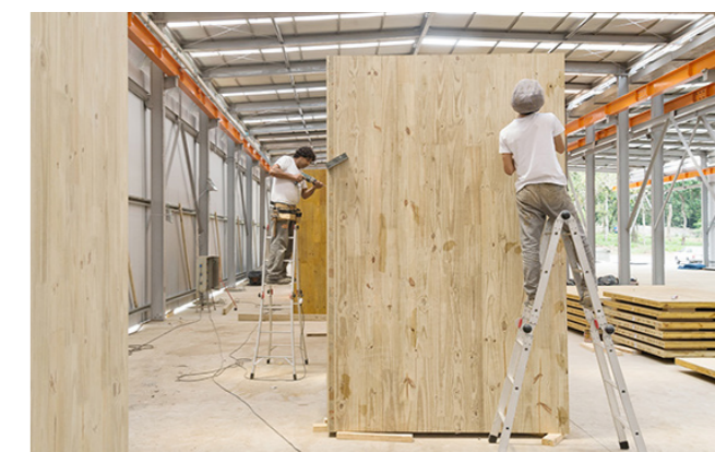
processo de montagem em fábrica dos módulos dos MINIMODs | fotografias do mapa
