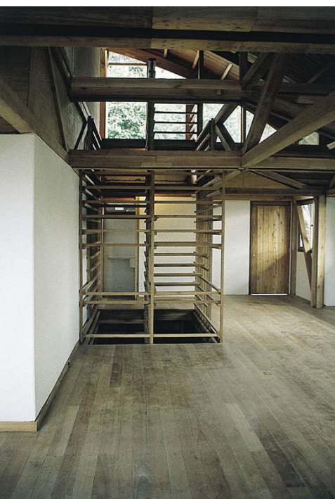
estrutura da escada vista da sala de estar |
