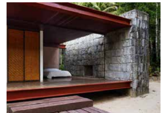
1.corte da casa rio bonito 2.fotografia do encontro entre a viga de aço e o muro de pedra | 1.desenho elaborado pela arquiteta 2. nelson kon
