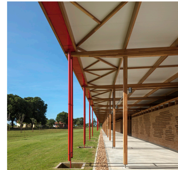
a relação exterior/interior provocada pela laje de concreto em contraste com a grama e pela delimitação visual que os pilares em linha | leonardo finotti
