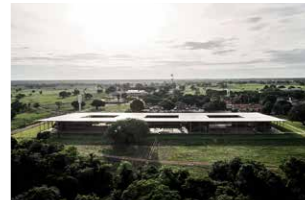
a cobertura massiva vista de cima | critobal palma
