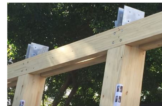
conectores metálicos que ficam no interior da estrutura | foto da obra - carpinteria
