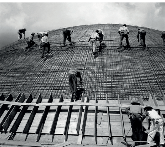
formas de madeira para a construção da cúpula da congresso em Brasília | marcel gautherot
