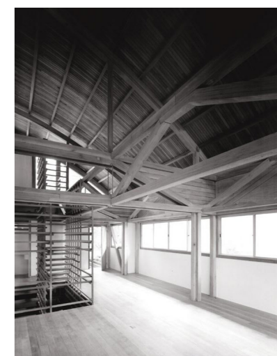
treliças e pórticos e cobertura curva | a. pappalardo
