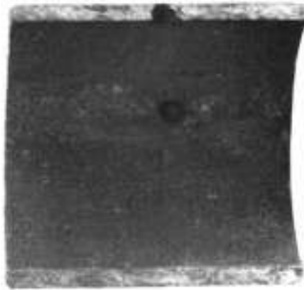
Figura II-XII Corrosão alveolar em tubo de aço carbono (FERREIRA et al,
