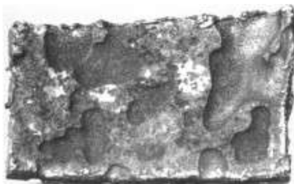
Figura II-XI Corrosão em placas em chapa de aço carbono de costado de tanque (FERREIRA et al, 2002).
