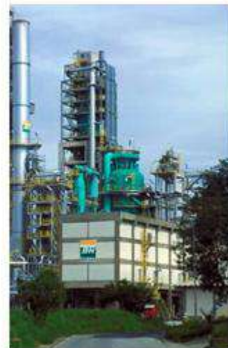
Figura 3. Unidade de craqueamento fluido catalítico da REDUC e da RECAP.
