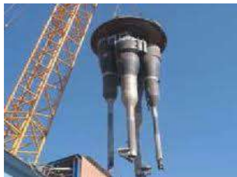
Figura 6. Ciclones do vaso separador de uma unidade de FCC.
