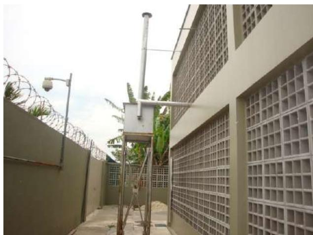
Figura 10. Silenciador utilizado.
