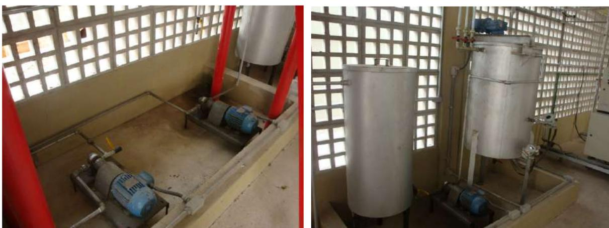
Figura 11. Fotos do tanque de diesel e de mistura e das bombas de engrenagem.
