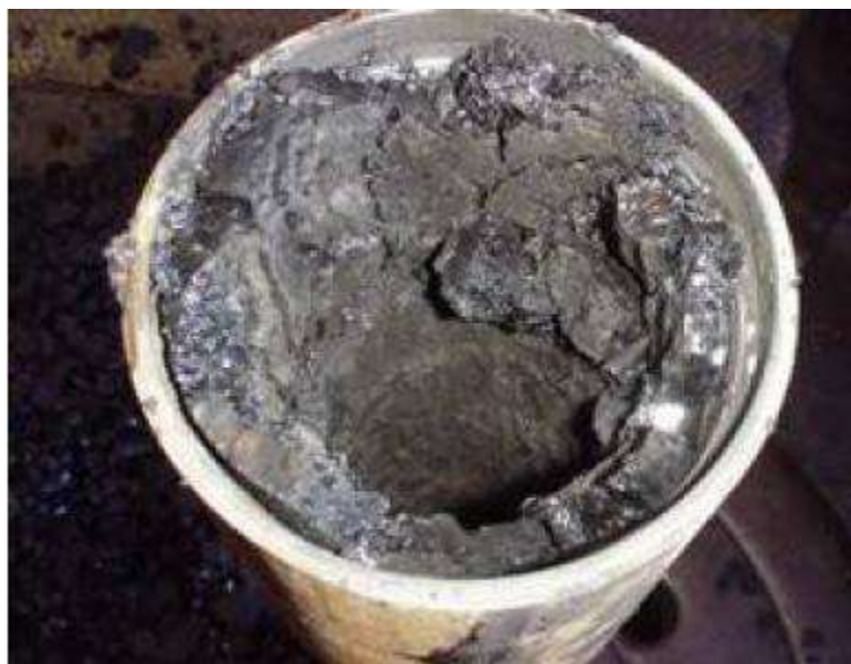
Figura I.1 Redução da seção útil de escoamento gerada pela deposição de asfaltenos (OLIVEIRA, 2006).
