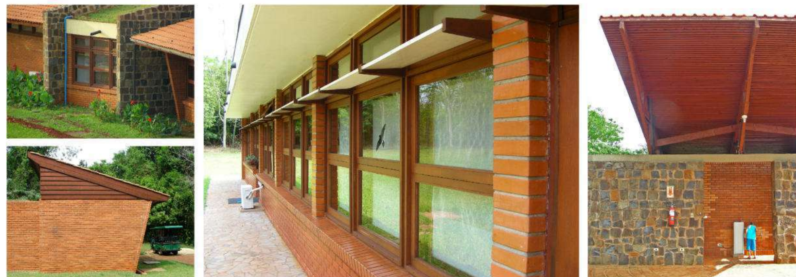
MATERIAIS APLICADOS NA CONSTRUÇÃO DO REFÚGIO FONTE: 3C ARQUITETURA URBANISMO
